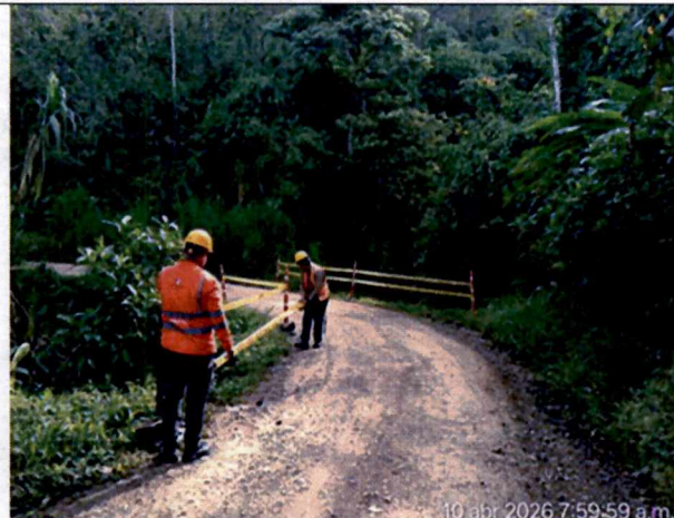
Foto 4. Reposición de delimitación de áreas de peligro
