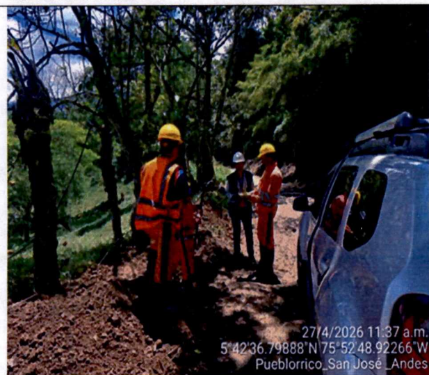
Foto 15. Recorrido a obra, verificación de uso de EPP
