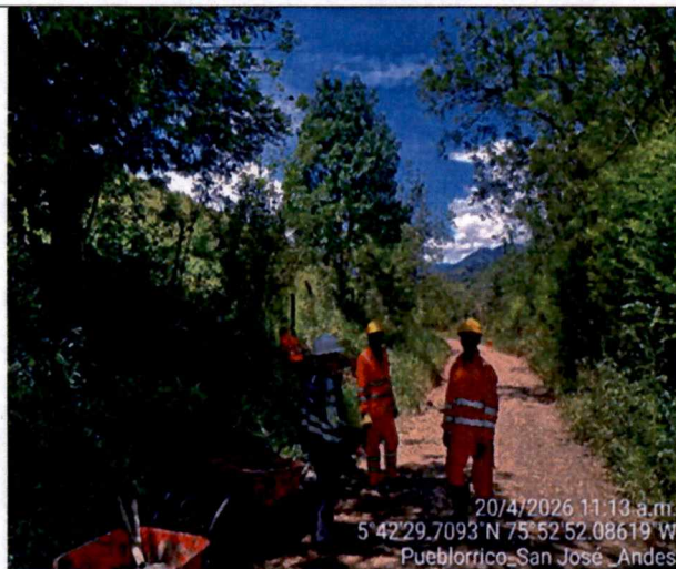
Foto 11. Recorrido de obra, verificación de uso de EPP y personal de obra
