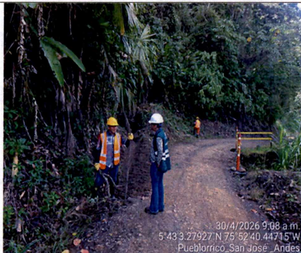
Foto 17. Recorrido a obra verificación actividades, peligros existentes y uso de EPP
