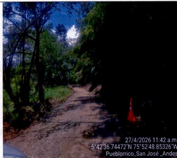
Foto 16. Permanencia de señalética interna de obra.
