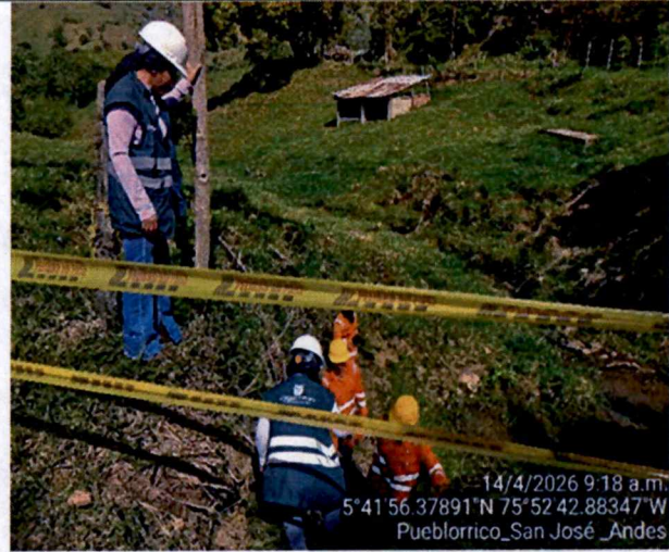
Foto 6. Recorrido frente de obra, verificación de actividades constructivas
