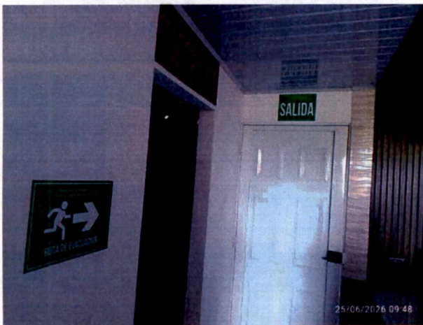
Foto 11. Señalización de rutas de evacuación
