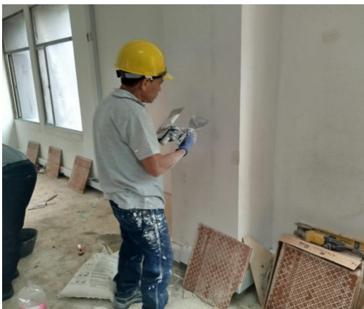
Imagen No.7: resane de juntas e imperfecciones
