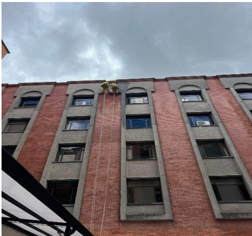
Imagen No. 12: Aplicación de hidrofugo
