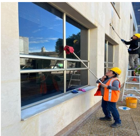
Imagen No. 14: Lavado y siliconado de ventanas
