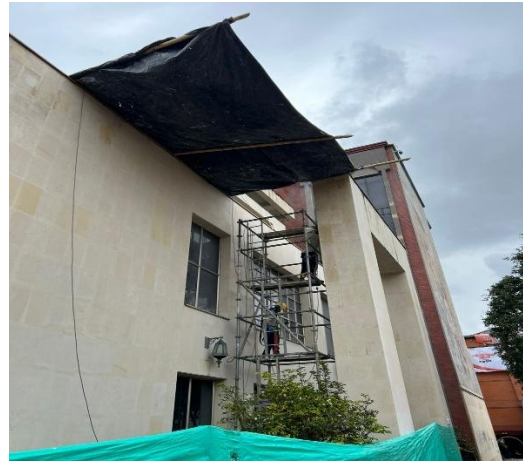
Imagen No. 13: Lavado y Aplicación de hidrofugo
