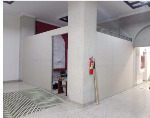
Imagen No.1: cerramiento provisional
