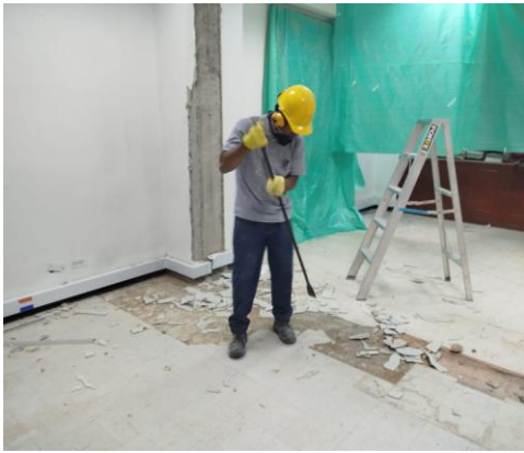
Imagen No.3: demolición de piso
