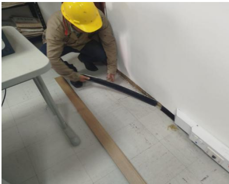
Imagen No.2: demolición de guarda escobas
