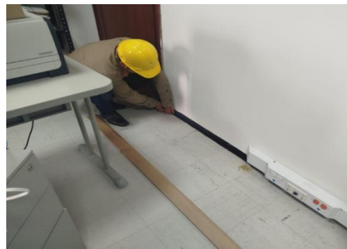
Imagen No.2: demolición de guarda escobas
