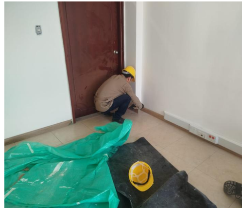
Imagen No.8: instalación de guarda escobas SPC
