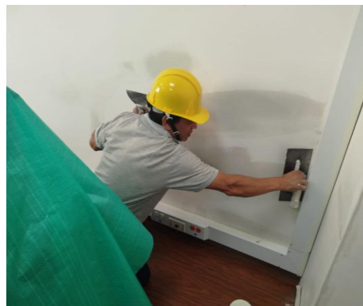
Imagen No.7: resane de juntas e imperfecciones
