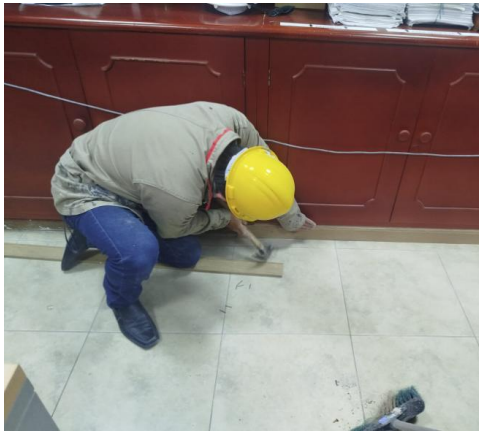
Imagen No.8: instalación de guarda escobas SPC
