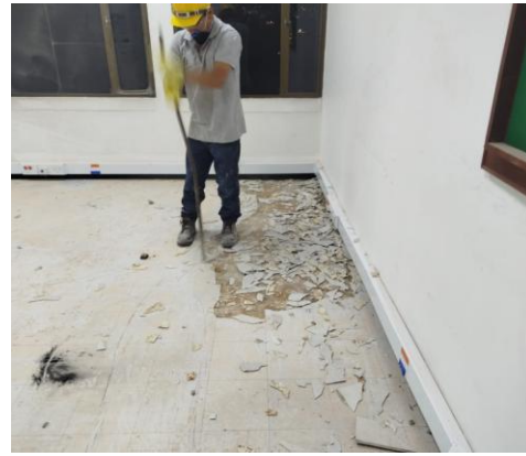
Imagen No.3: demolición de piso
