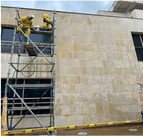
Imagen No. 13: Lavado y Aplicación de hidrofugo
