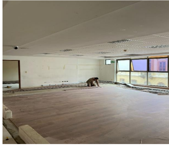
Imagen No. 11: Instalación de piso vinílico
