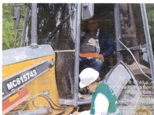
Foto 2. Firma de Preoperacionales en obra.
