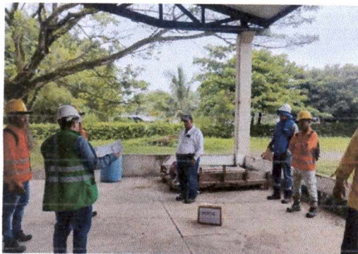
Foto 5. Inducción de personal en la vía Remedios- Y de la virgen- Puerto Berrio.
