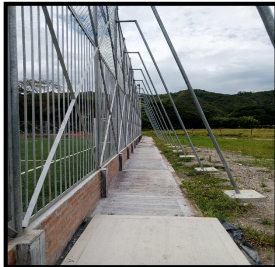
Tubería galvanizada 2" cal 2mm incluye anclajes, tapa
