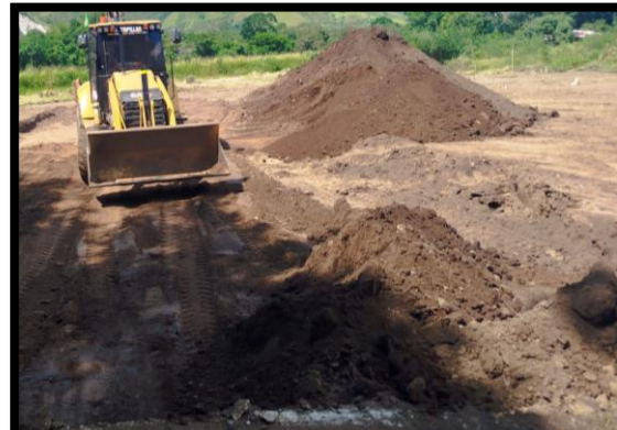
Excavación mecánica incluye retiro 1 km
