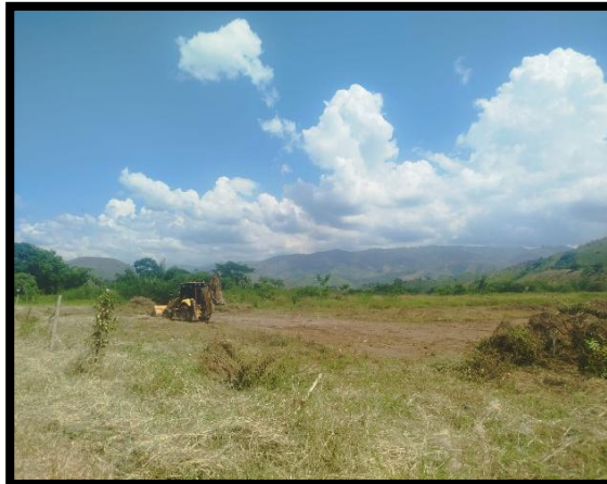
Descapote e=0,20m a máquina incluye retiro material
