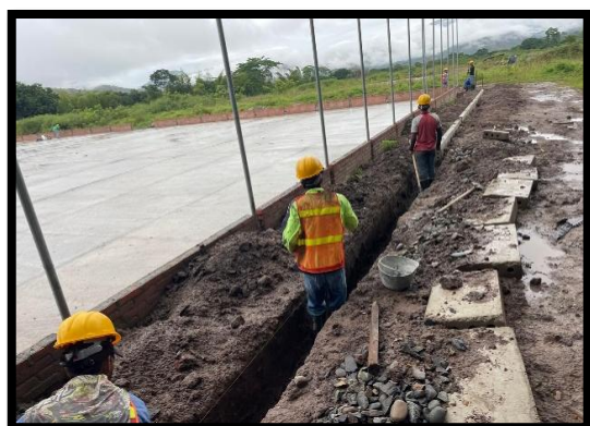
Excavación manual incluye retiro
