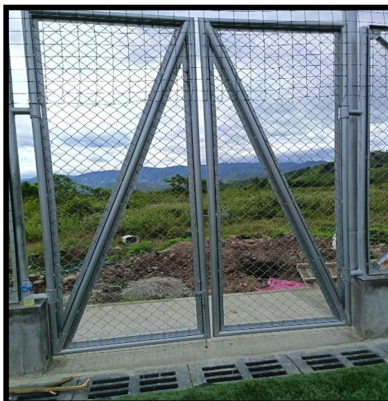
Tubería galvanizada 2" cal 2mm incluye anclajes, tapa
