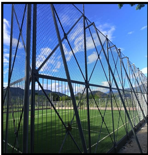
Tubería galvanizada 2" cal 2mm incluye anclajes, tapa
