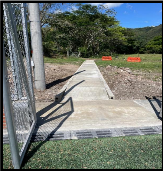
Concreto 3000 psi andenes perimetrales e=8cm, incluye malla electrosoldada y formaleta
