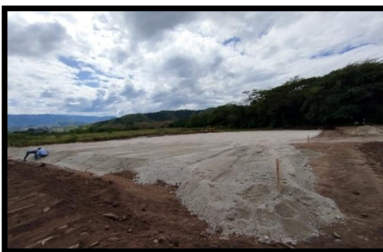
Rellenos con recebo compactado mecánicamente
