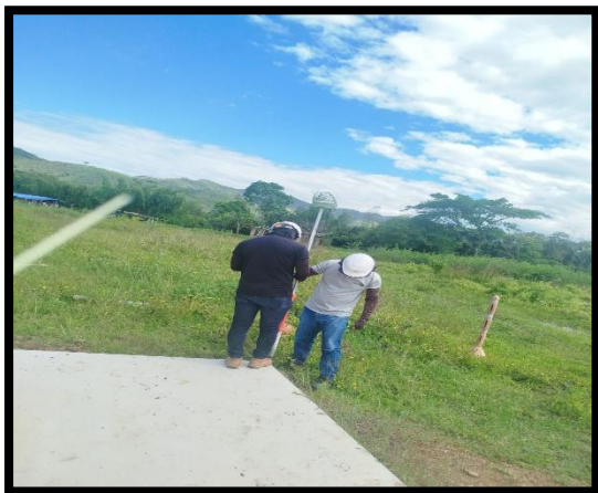
Localización y replanteo
