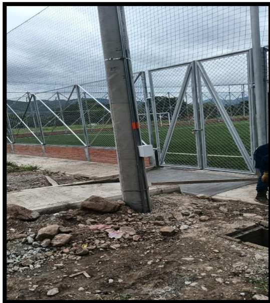
Salida Parcial Eléctrica (2 THHN No.10 + 1 THHN No.12)
