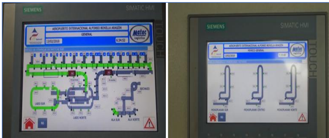
SCADA bandas de equipajes
