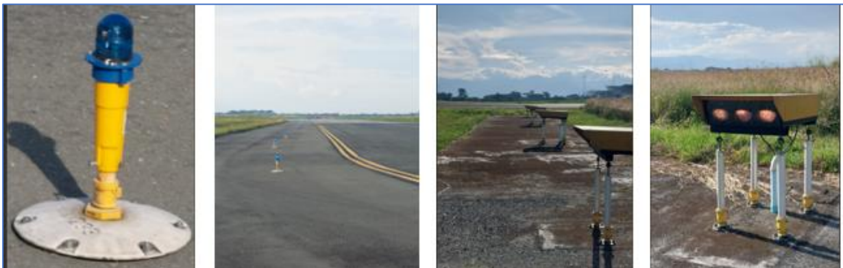
Sistemas de iluminación de pista, luces PAPI
