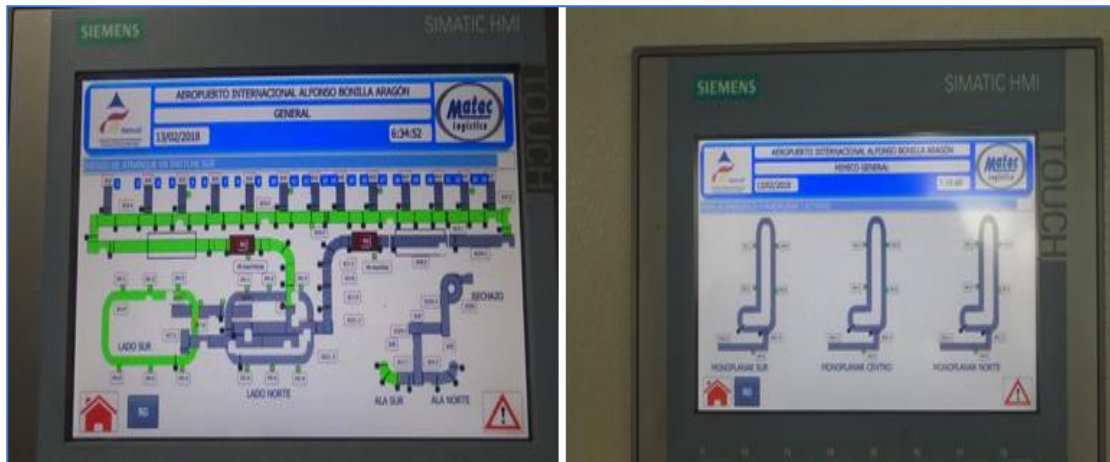
SCADA bandas de equipajes
