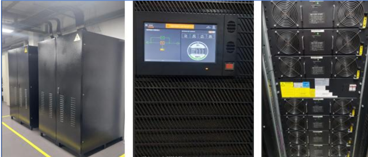
Sistemas ininterrumpidos de potencia (UPS)
