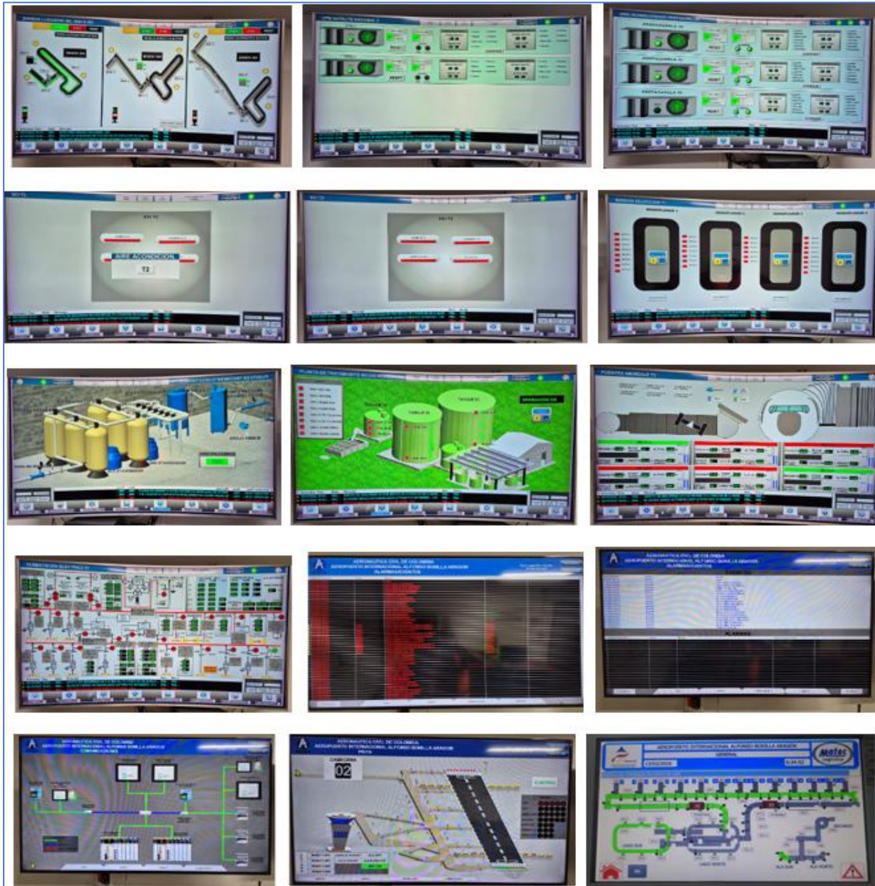
SCDA lado aire y lado tierra.
