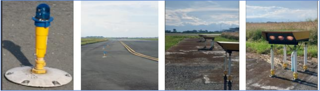
Figura 7. Sistemas de iluminación de pista, luces PAPI
