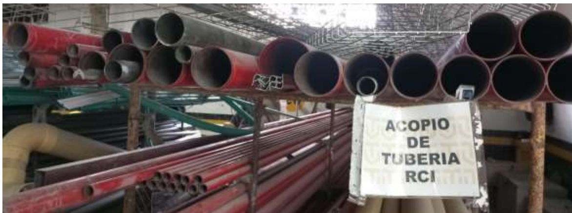
Ilustración 7. Acopio tubería RCI
