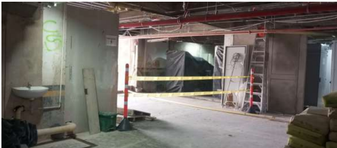
Evidencia 6. Señalización de área
