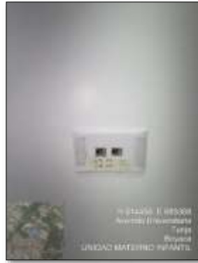
Imagen 12. Salida doble para voz y datos
