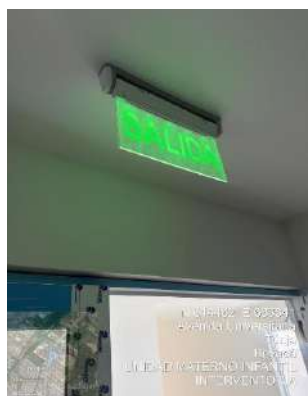
Imagen 21. Salida de emergencia
