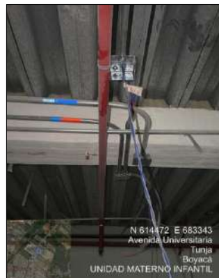
Imagen 16. Red de Parlanteo Sótano
