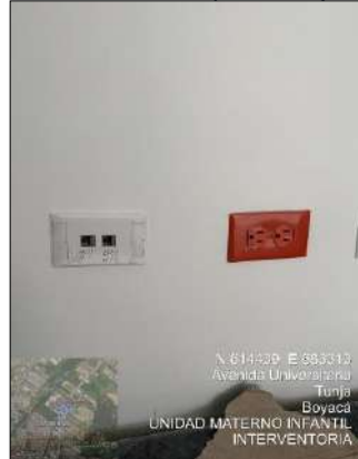
Imagen 2. Salida Doble para voz y datos
