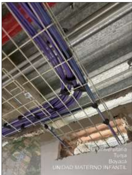
Imagen 16. Cable FPLR 2x16 para red de Parlanteo
