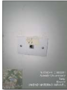
Imagen 13. Salida sencilla para voz y datos
