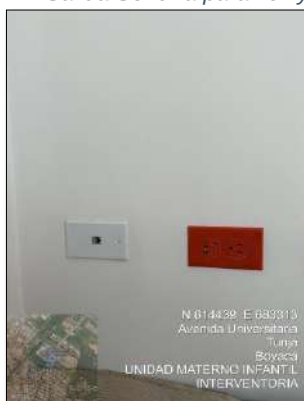
Imagen 4. Salida Sencilla para voz y datos
