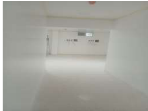
Evidencia 9. Ejecución de actividades
