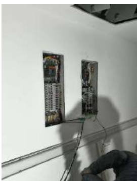
Instalación de totalizadores.
