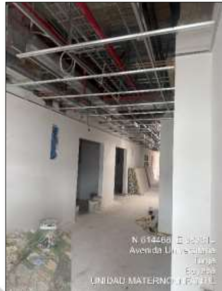
Imagen 15. Tubería RCI
