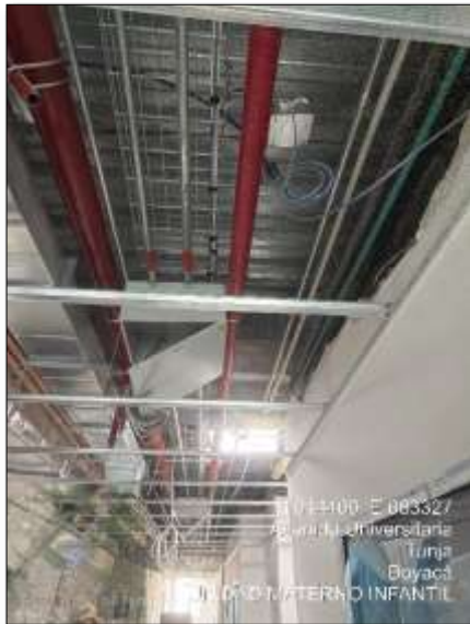
Imagen 14. Tubería RCI
