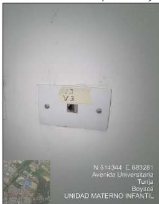
Imagen 5. Salida sencilla para voz y datos
