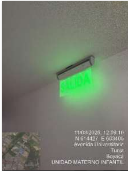
Imagen 18. Salida de emergencia
