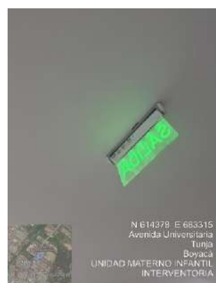
Imagen 22. Salida de emergencia
