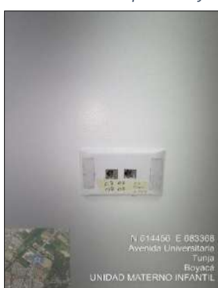
Imagen 6. Salida doble para voz y datos
