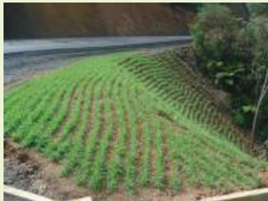
Revegetalización de taludes en zonas intervenidas.
