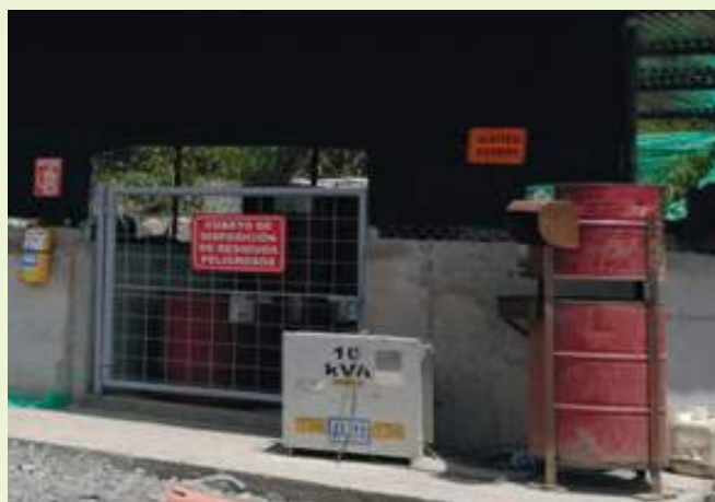
Cuarto de almacenamiento de residuos peligrosos.
