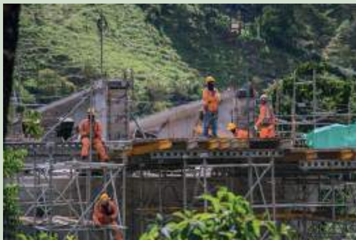
Trabajos en altura.
