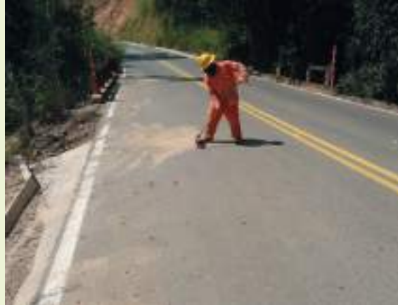
Limpieza de vías afectadas por la obra.
