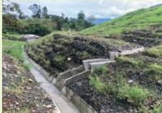
Obras de drenaje para el manejo de aguas de escorrentía.
