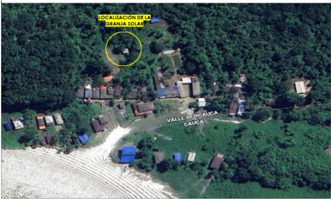
Ilustración 5: Localización actual de la infraestructura existente
