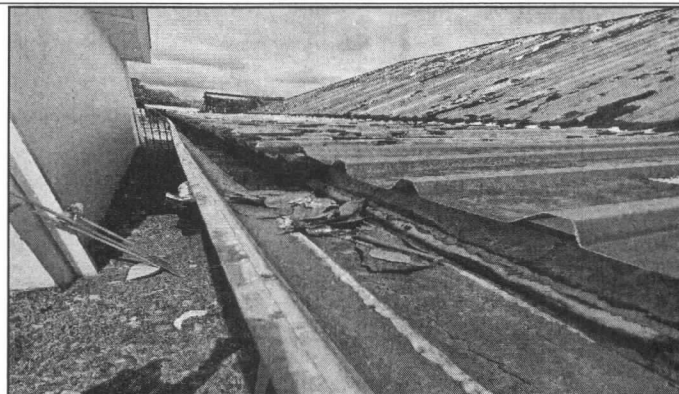
FOTO No 2: Canal Deteriorado
