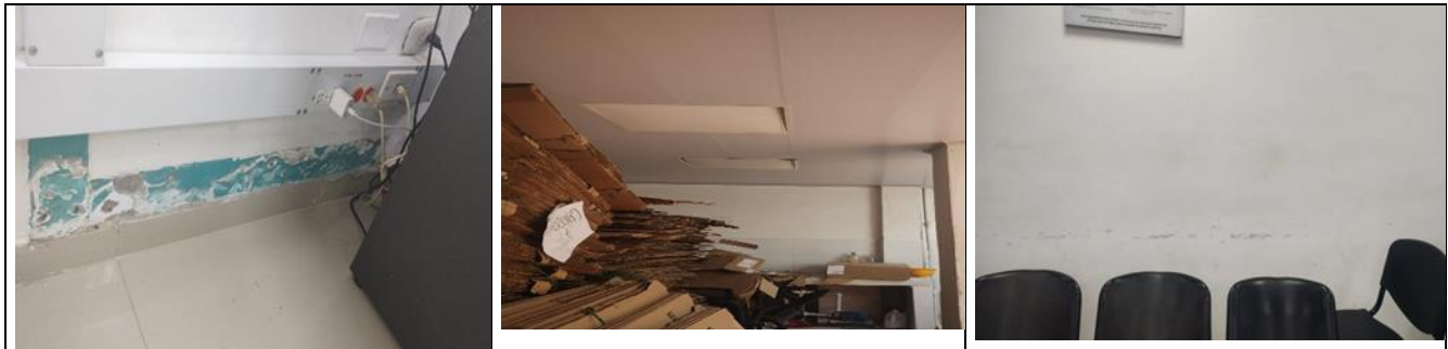
Imagen. Estado actual inmueble Registraduría Municipal de Magangue.
