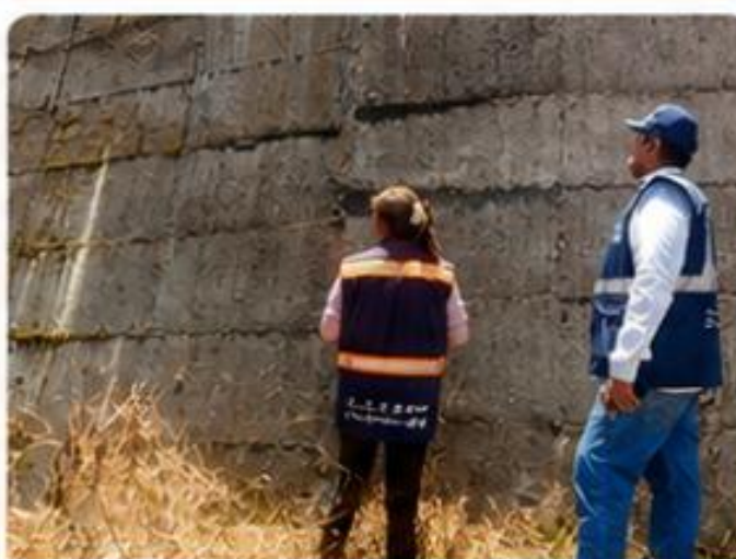
MUROS DE CONTENCIÓN
