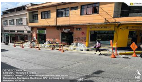
Demolición de andenes y sardineles
