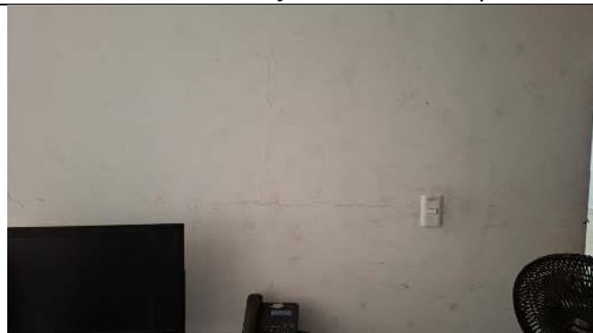
Ingreso oficina subdirectora SARN
