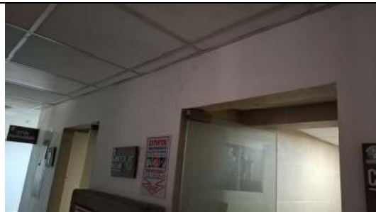
Baño hombres piso 3
