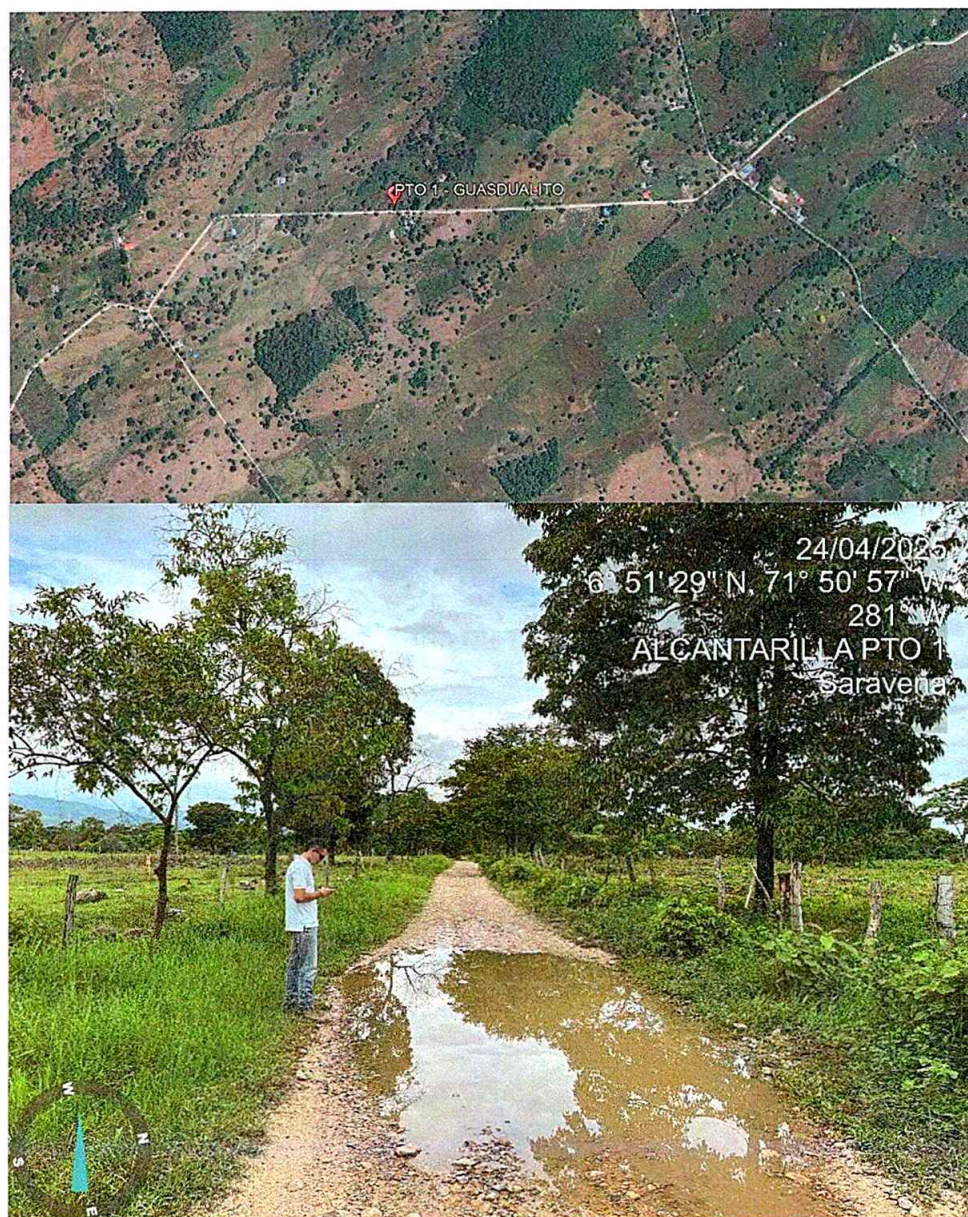
Figura 3 Punto de intervención Vereda Guas dualito Fuente: Tomado de informe topográfico
