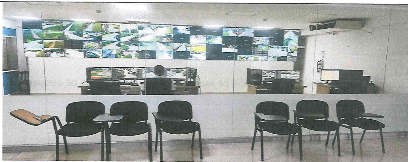
Registro fotográfico del estado actual sala de monitoreo
