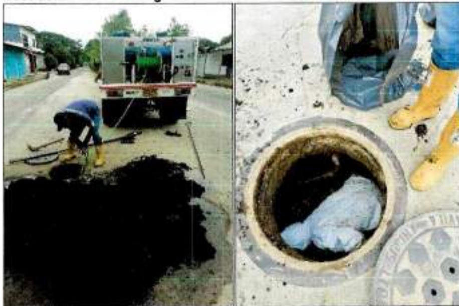
Ilustración 12. Fotografías de Mantenimientos a redes de Alcantarillado
