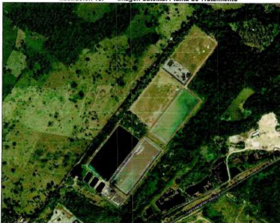
Ilustración 15. Imagen Satelital Planta de Tratamiento
