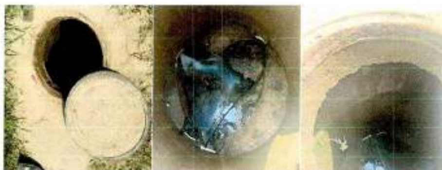
Registro fotográfico pozo PZE_6 Fuente: propia.
