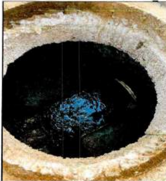
Registro fotográfico pozo PZE_12 Fuente: propia.
