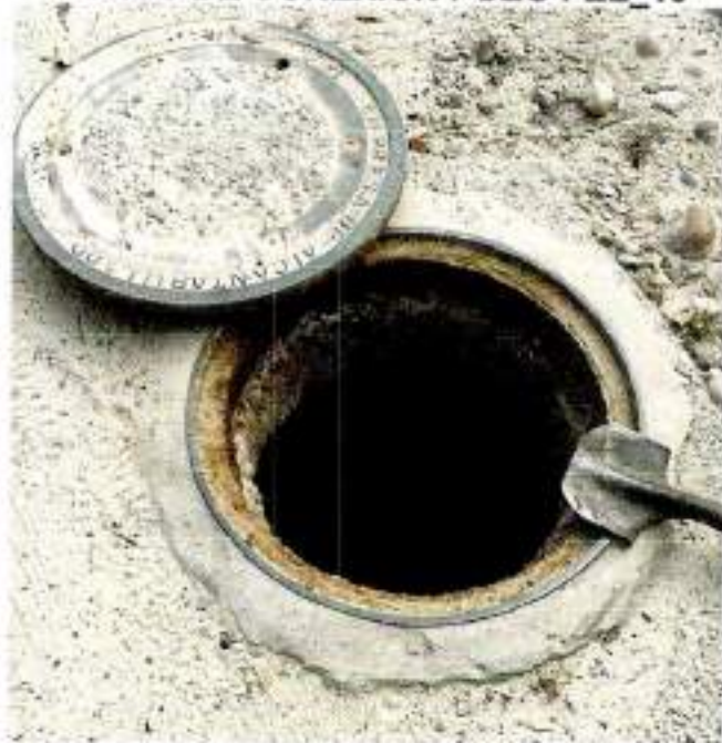
Registro fotográfico pozo PZE_13
