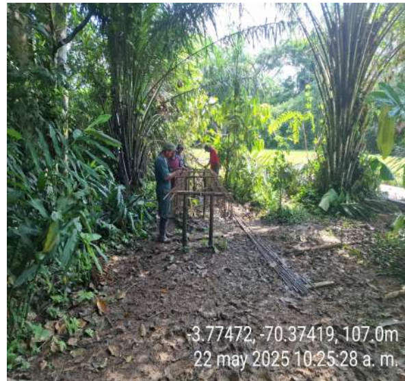
figurado acero refuerzo bordillos tramo 3 (internado)
