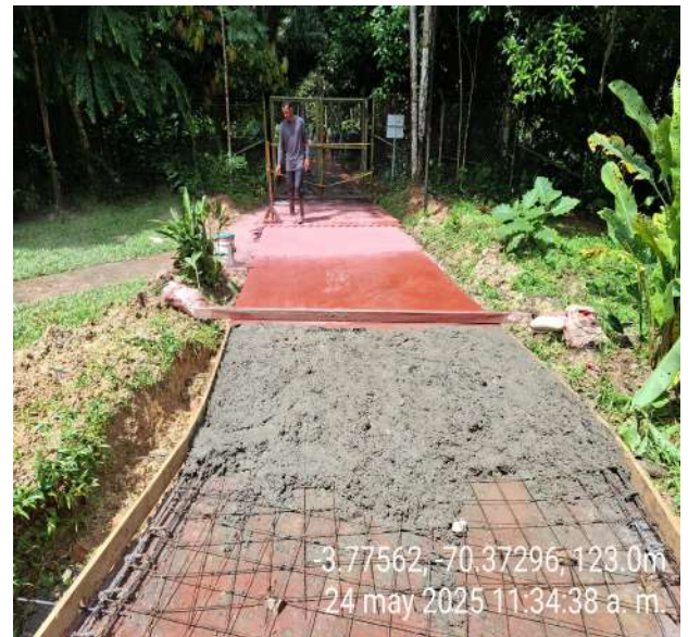
CONCRETO PARA SENDERO TRAMO 3
