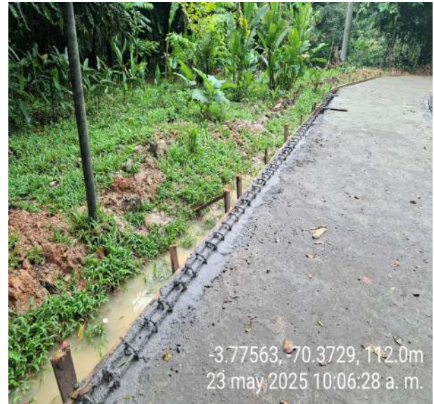
CONCRETO PARA BORDILLO TRAMO 3
