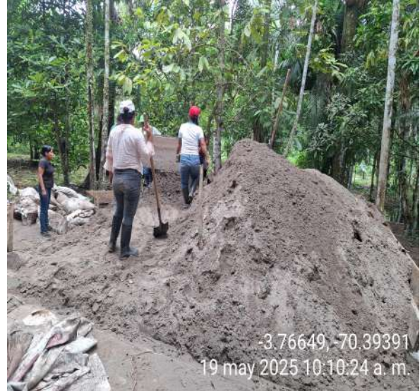
Acopio de material
