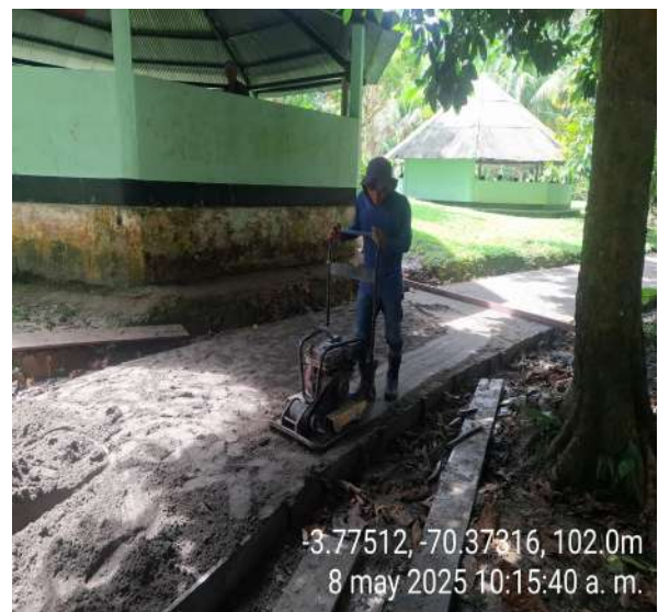
Base arena/cemento Pr 0+220 tramo 3 (internado)
