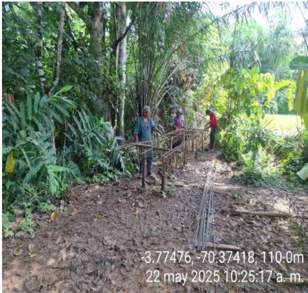
FIGURADO ACERO PARA BORDILLO TRAMO 2
