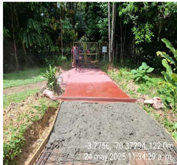
Sendero Peatonal en concreto Pr 0+290 tramo 3 (internado)
