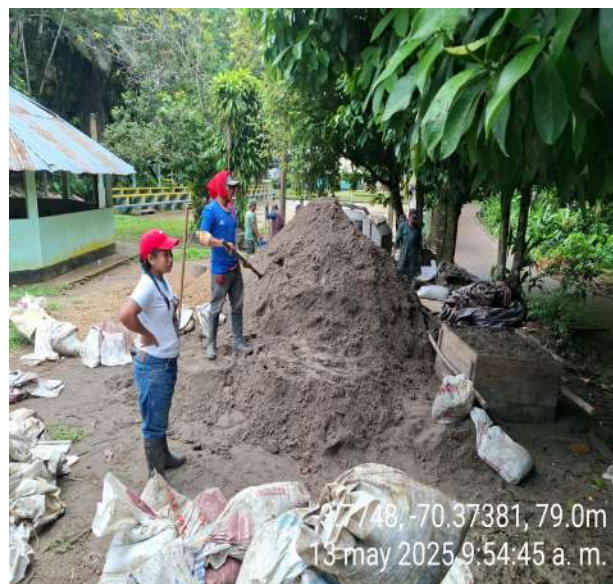
ACOPIO DE ARENA TRAMO 3 (INTERNADO)
