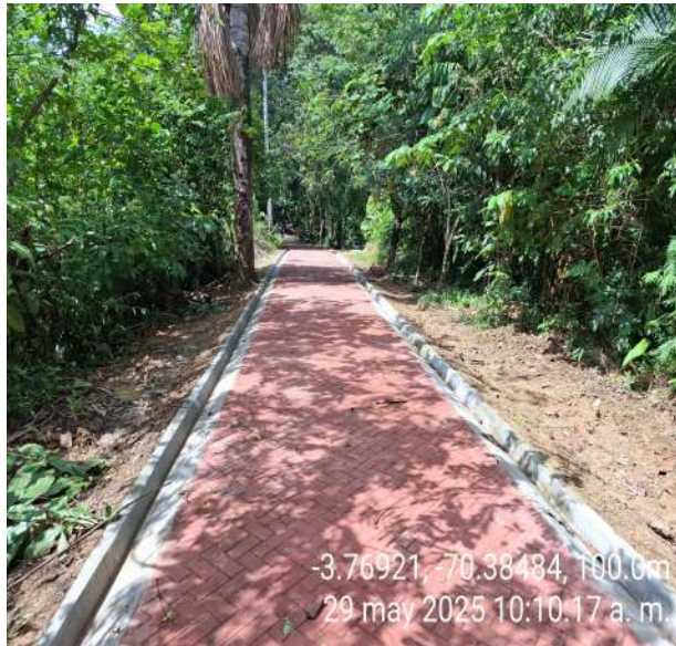
CONCRETO PARA CUNETAS TRAMO 2
