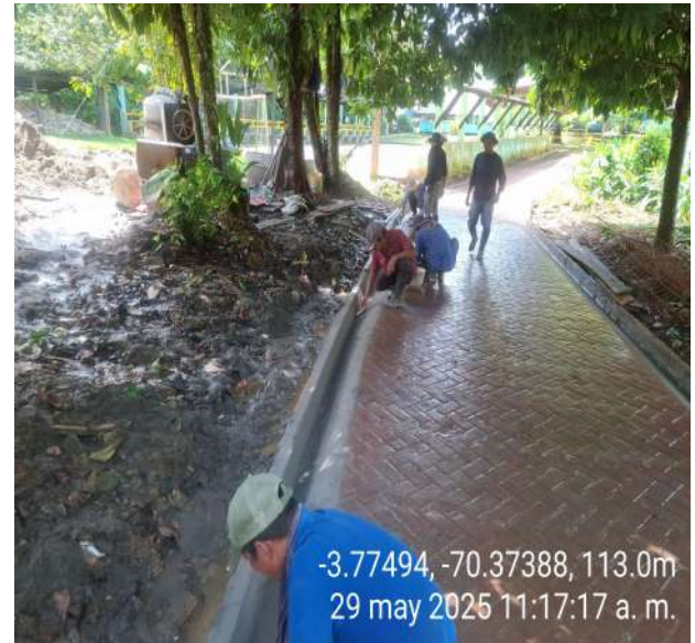
CONCRETO PARA CUNETAS TRAMO 3
