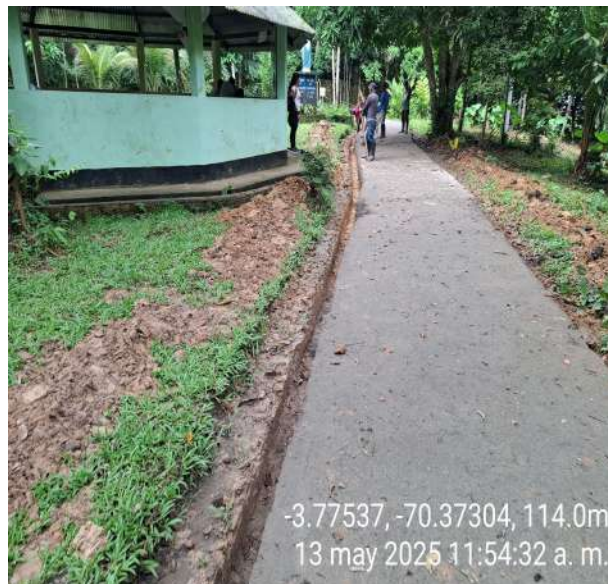
EXCAVACIÓN PARA BORDILLO TRAMO 3
