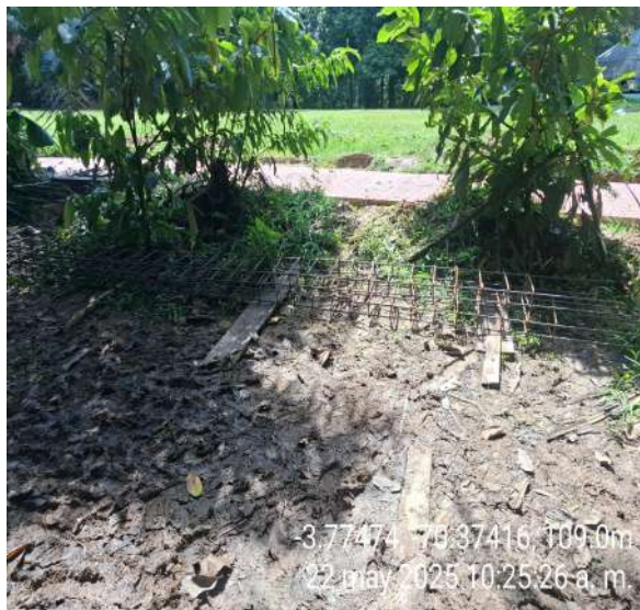
Acero refuerzo para bordillo tramo 3
