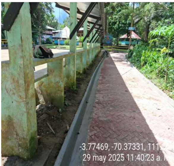
Concreto para cunetas tramo 3 (internado)
