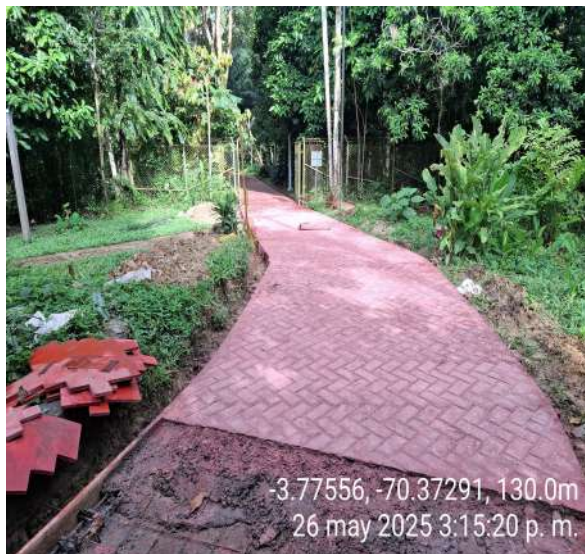
Sendero Peatonal en concreto Pr 0+280 tramo 3 (internado)
