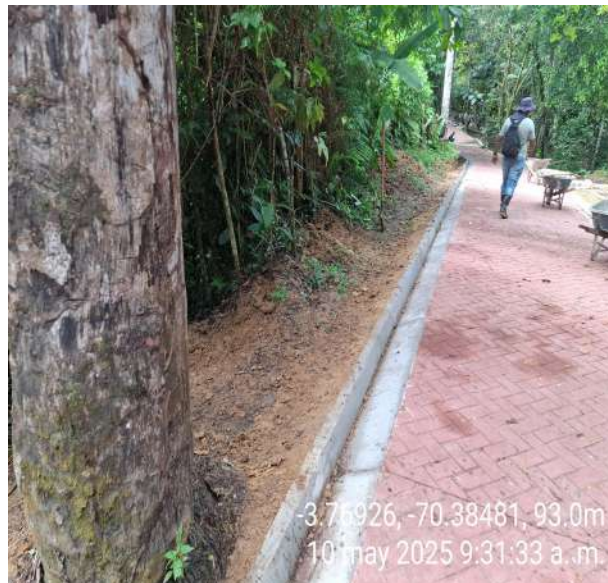
RELLENO COSTADOS CUNETAS TRAMO 3
