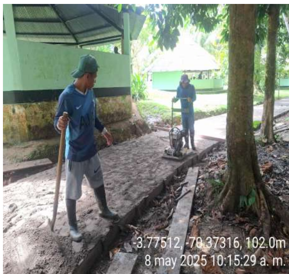
Base arena/cemento Pr 0+230 tramo 3 (internado)
