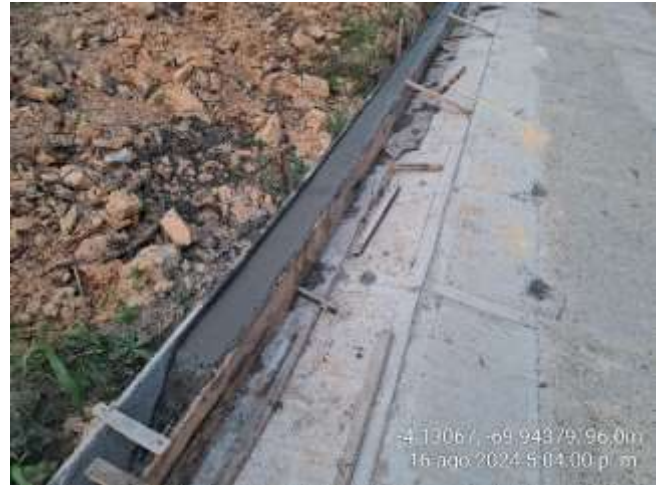
Construcción de bordillos km9
