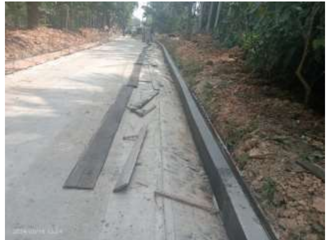
Construcción de bordillos km9
