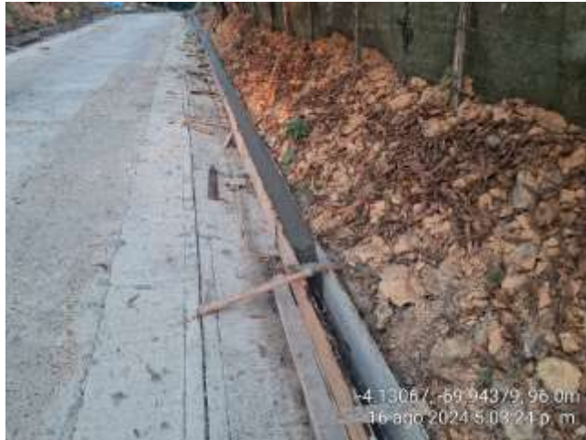
Construcción de bordillos km9
