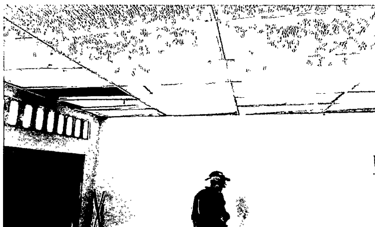
Cielorrasos que deben ser retirados, se encuentran colapsados
