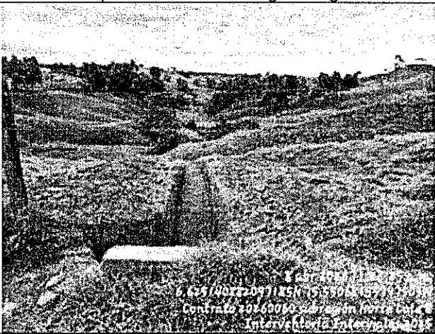
Limpieza de obras
