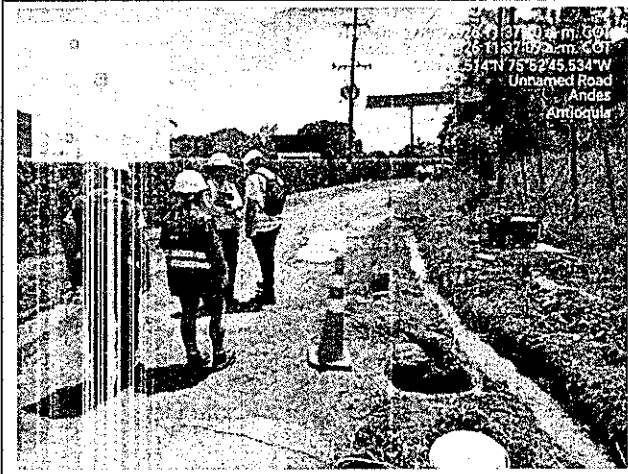
Presencia de manhole
