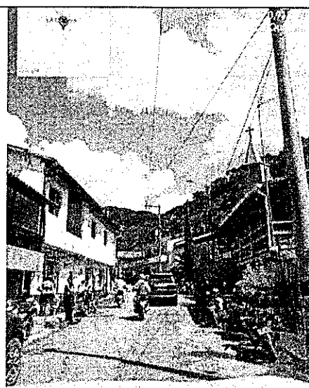
Pavimento corregimiento "La Cámara".
