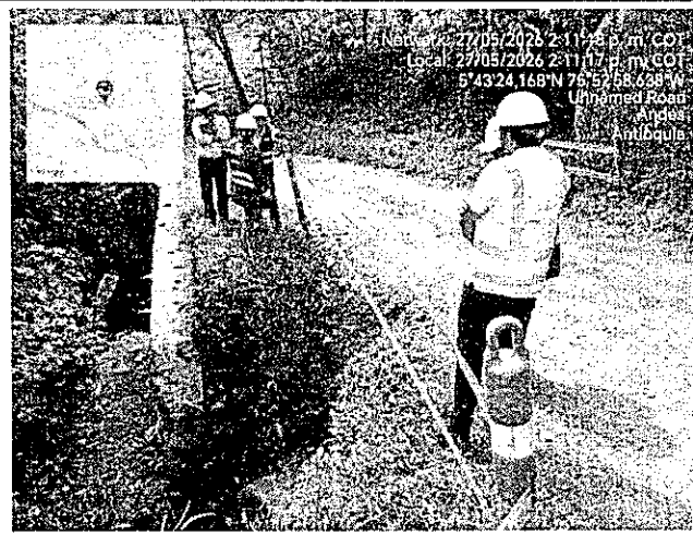
Socavación descole obra transversal
