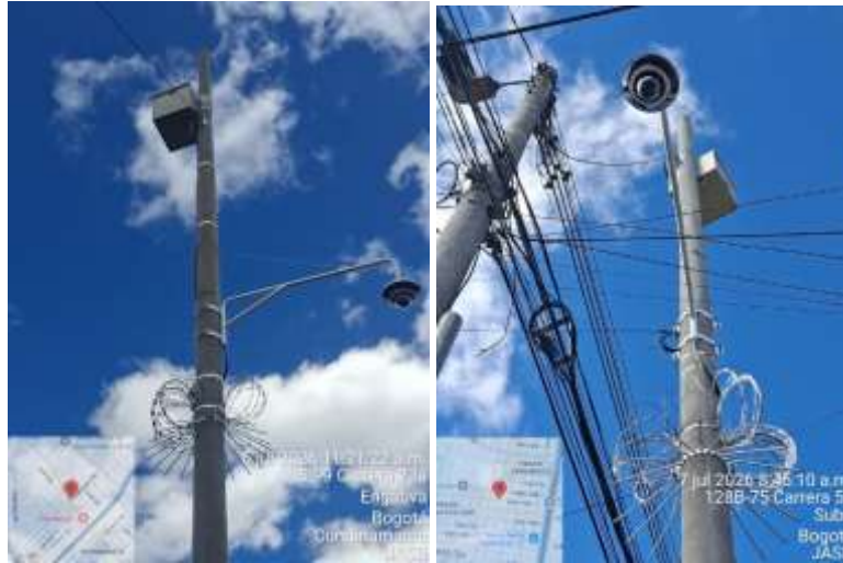
Ilustración 5. Instalación fibra óptica cámaras Multisensor
