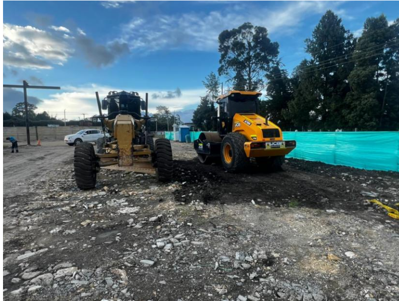
Ilustración 4. Motoniveladora y vibrocompactador
