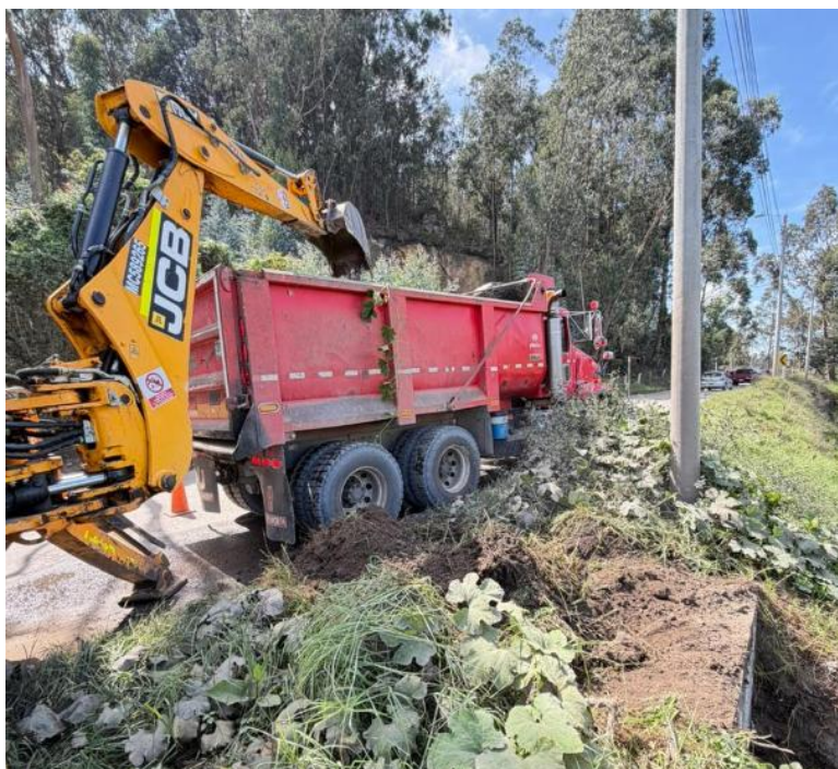
Ilustración 3. Retroexcavadora y volqueta
