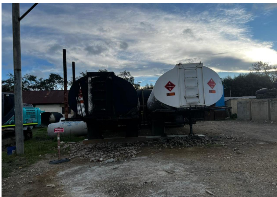
Ilustración 7. Tanque de almacenamiento
