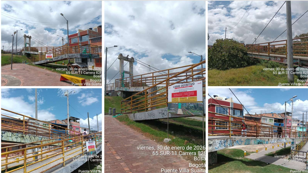
Registro Fotográfico. (Puente antes de la demolición)
