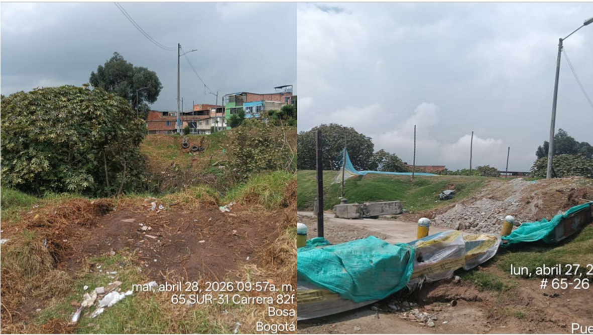
Registro Fotográfico. (Puente después de la demolición)
