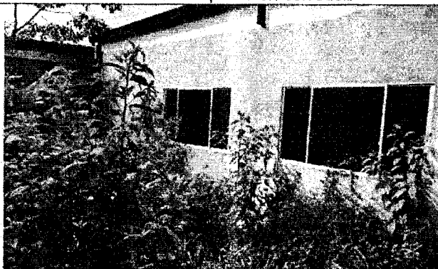
Imagen No 3. Fachada posterior, patio – Vegetación a alturas mayores a 1,00m, zonas húmeda, sin adecuación ni utilidad de espacio disponible.
