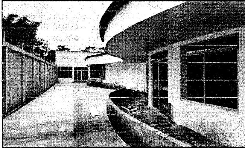
Ilustración 03. Infraestructura actual. - Fuente: Propia.
