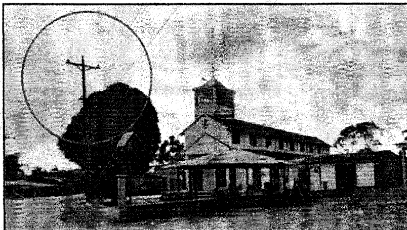
Ilustración 05. Conexión eléctrica existente. Fuente: Propia.
