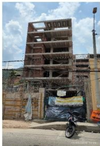
Construcción licenciada bajo acto administrativo 2399 de 2022 adyacente a la casa de la cultura BIC
