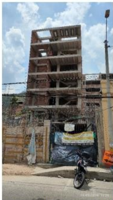
Construcción licenciada bajo acto administrativo 2399 de 2022 adyacente a la casa de la cultura BIC
