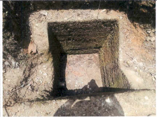
Foto 12. Limpieza de cunetas
