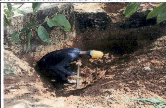
Foto 4. Visita de campo, limpieza e inspección de alcantarillas.
