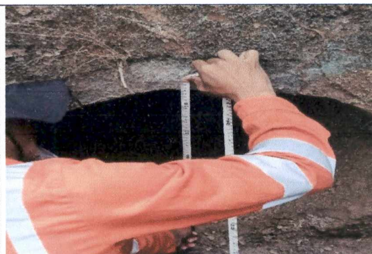
Foto 14. Medidas e inventario de alcantarillas
