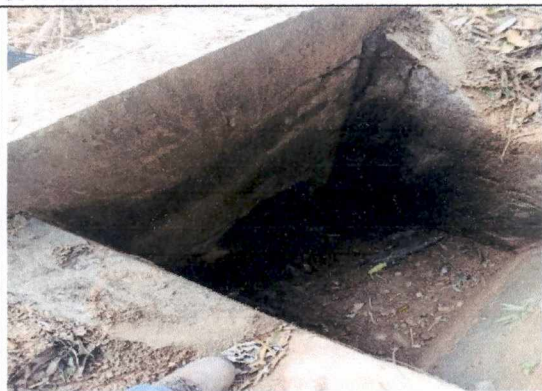
Foto 8. Limpieza de alcantarillas en la zona
