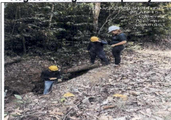
Foto 7. Limpieza y mantenimiento de alcantarillas - cunetas
