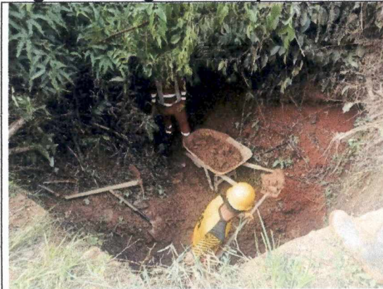
Foto 11. Limpieza de cunetas y alcantarillas tramo K20 – K22
