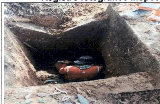
Foto 3. Visita de campo, limpieza e inspección de alcantarillas
