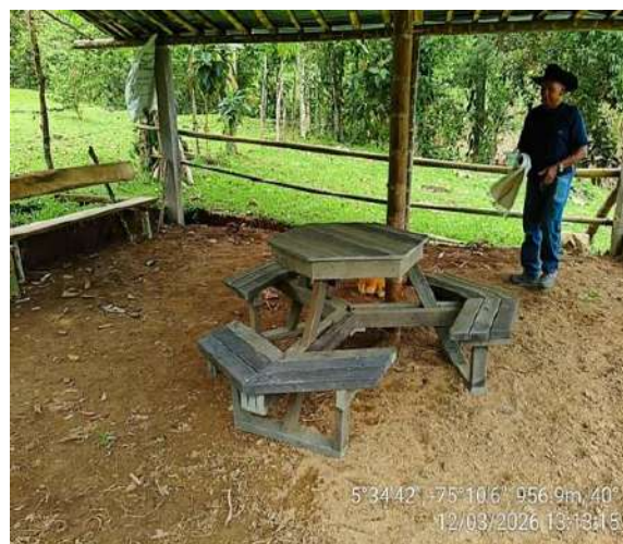
INSTALACIÓN DE MESA HEXAGONAL.
