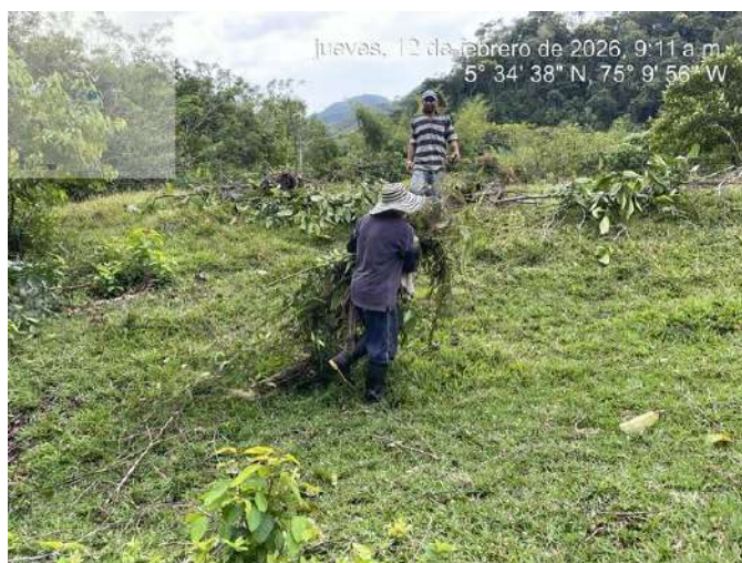
CARGUE DE MATERIAL FUERA DEL CAUSE.
