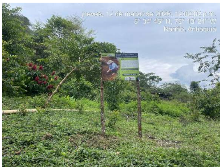
INSTALACIÓN DE POSTER EN POLIETILENO.
