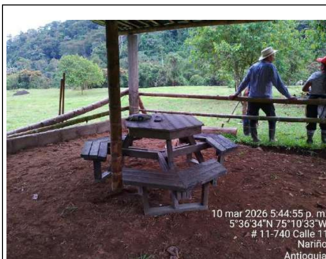
INSTALACIÓN DE MESA HEXAGONAL.
