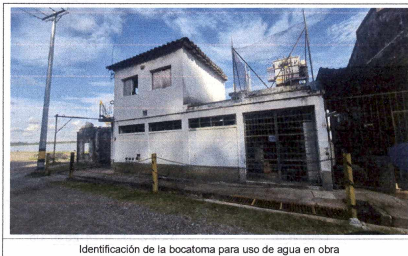
Ilustración 7. Bocatoma para uso del agua en obra
