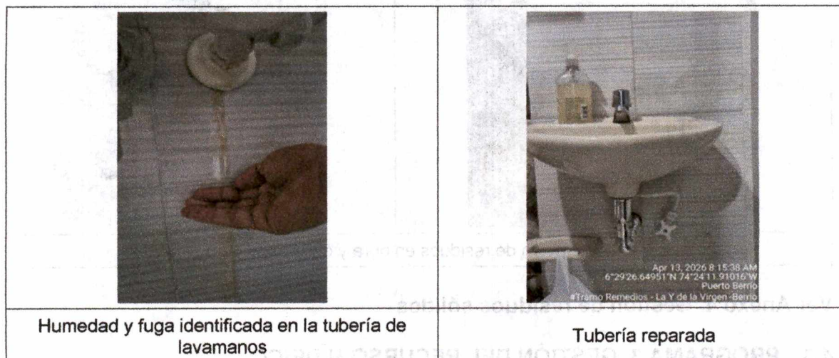
Ilustración 8. Identificación y reparación de fugas
