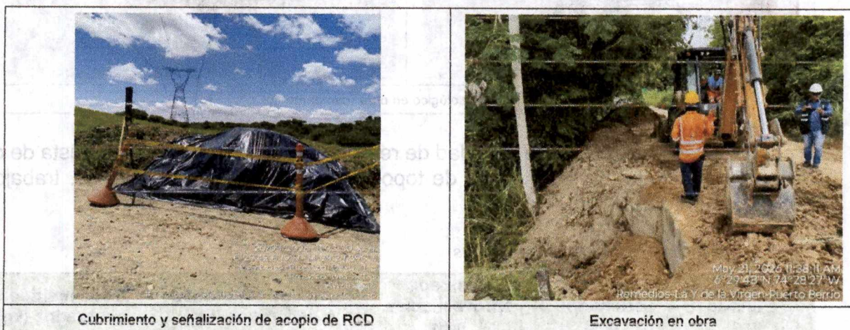
Ilustración 8. Gestión de residuos de construcción y demolición
