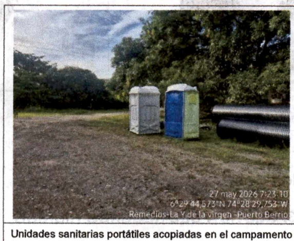
Ilustración 11. Unidades sanitarias para instalación
