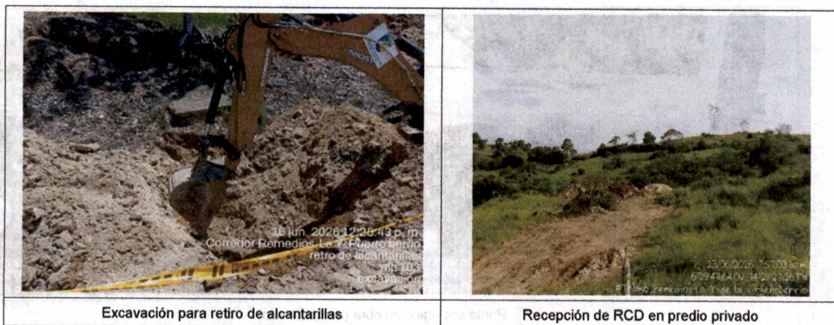
Ilustración 6. Gestión de residuos de construcción y demolición
