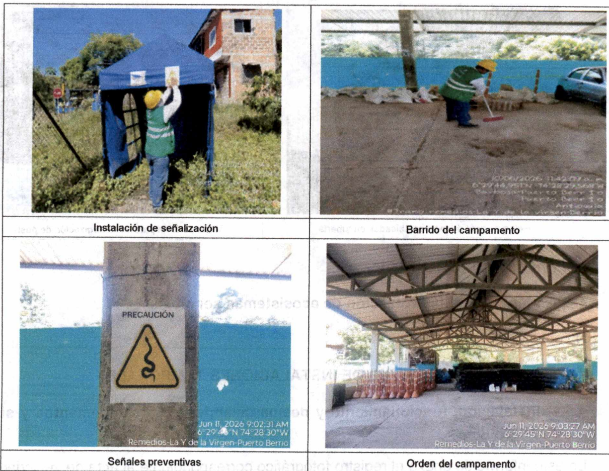
Ilustración 16. Registro fotográfico acopio (campamento)
