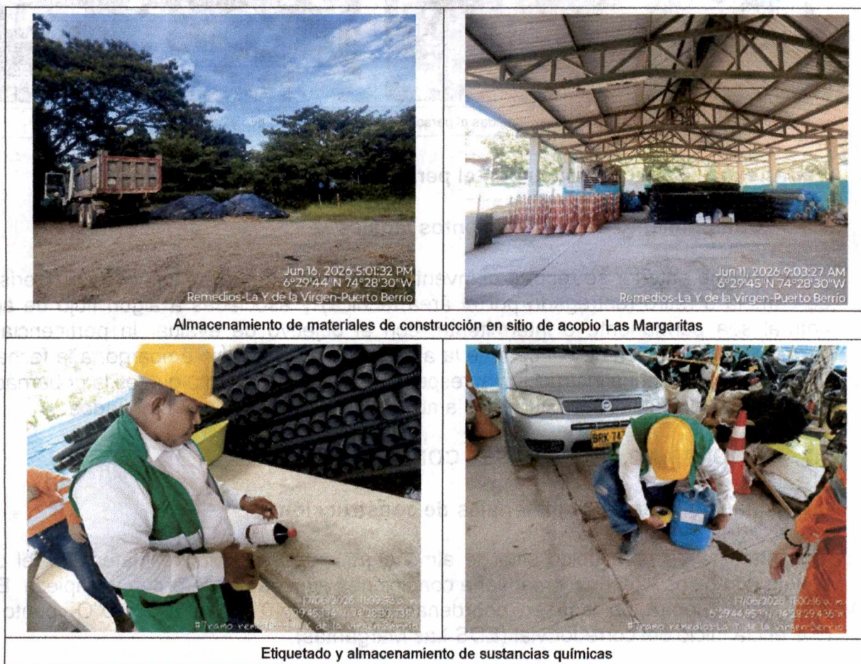
Ilustración 4. Registro fotográfico almacenamiento de materiales de construcción
