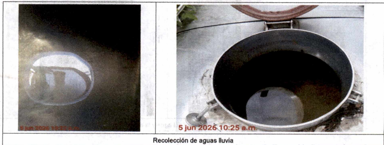
Ilustración 11. Registro fotográfico recolección de aguas lluvias
