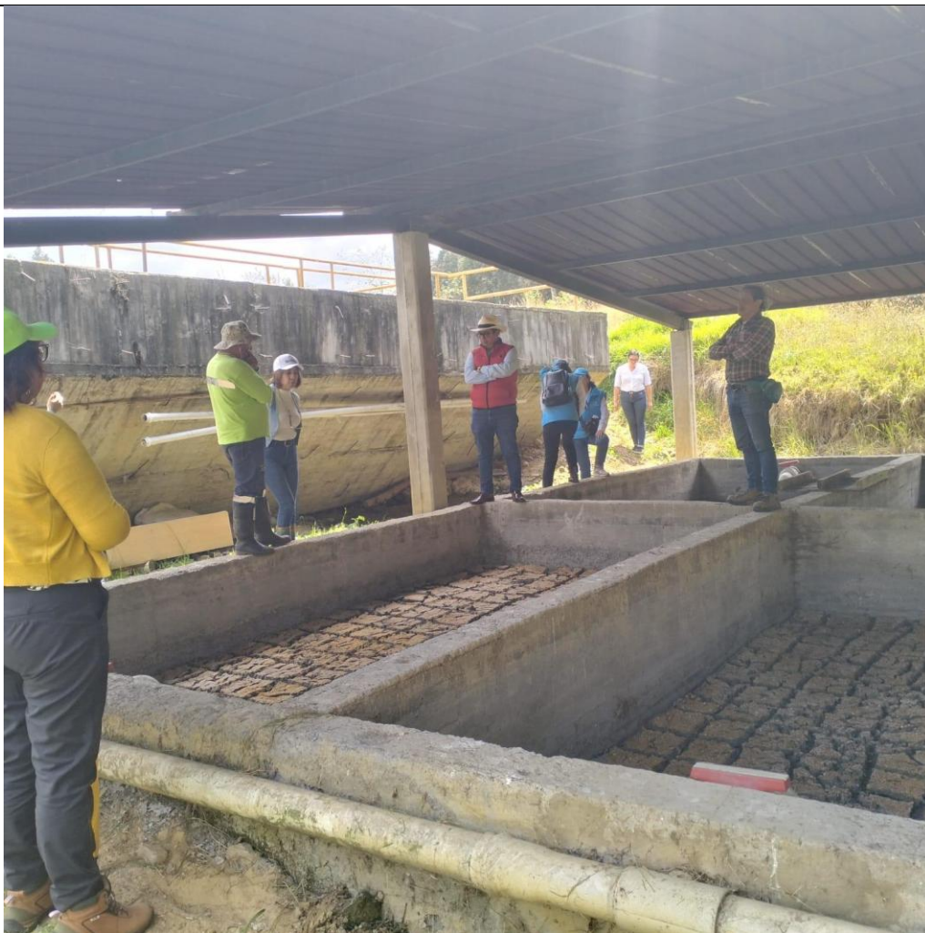
Inspección judicial PTAR Casco Urbano Guasca 21/01/2026
