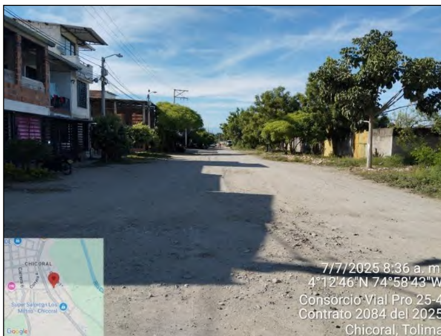
Fotografía 1. Estado inicial del TRAMO 35. Barrio Villa Inés CRA 1 - VÍA SAN ANTONIO - VIÑEDO.
