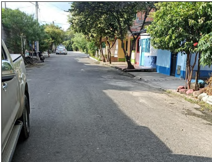
Fotografía 6. Estado inicial del TRAMO 40. Barrio Nueva Carrera 10 entre calle 1a a 2.
