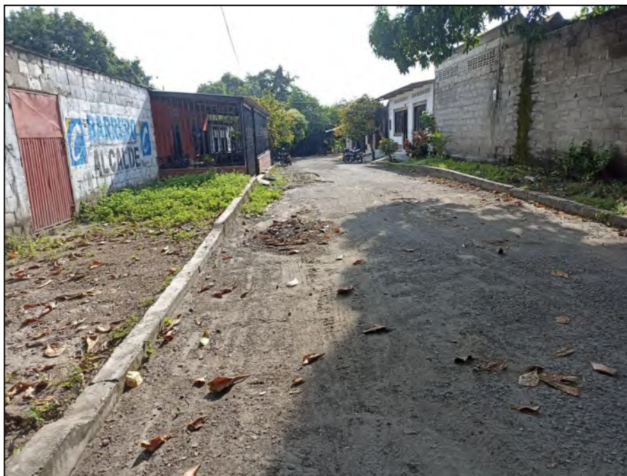
Fotografía 5. Estado inicial del TRAMO 39. Barrio Nueva Calle 1a entre carrera 9 y fin (cerrada).
