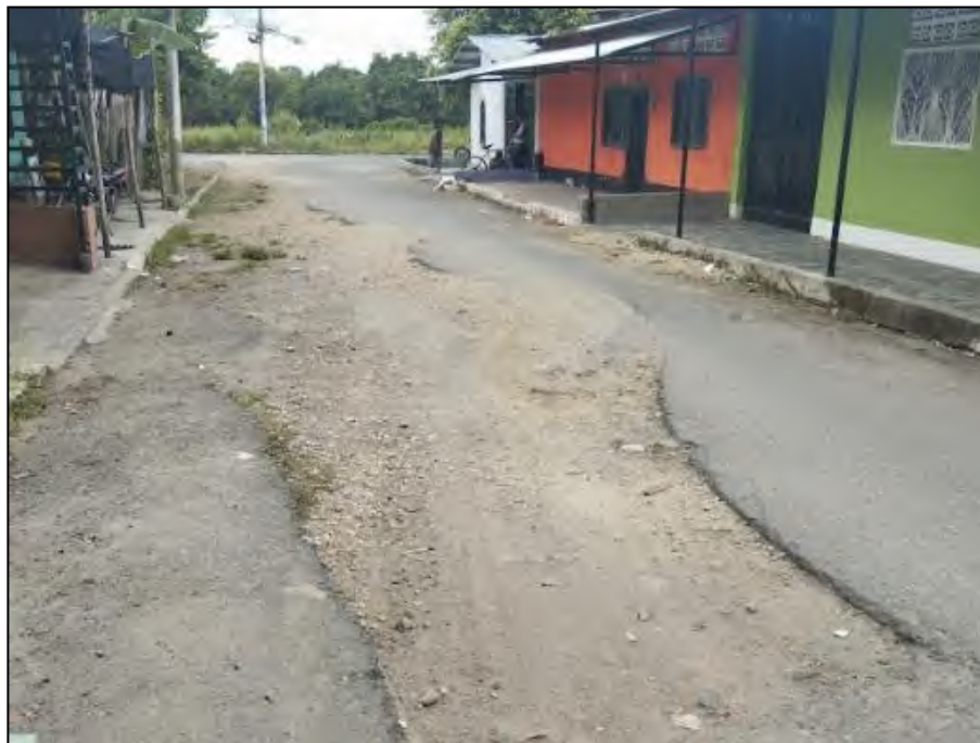
Fotografía 4. Estado inicial del TRAMO 38. Barrio Villa Nueva Carrera 9 entre calle 1 a2.
