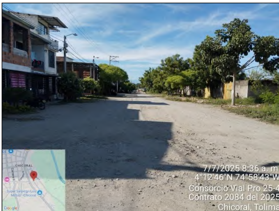
Fotografía 3. Estado inicial del TRAMO 37.1. Barrio Villa Inés Carrera 2 entre calle 1 a 3.
