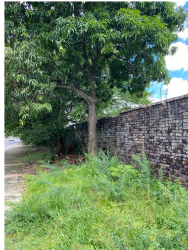
Tramos desde el sitio de colapso hasta la esquina de la Carrera 23 con Calle 37.
