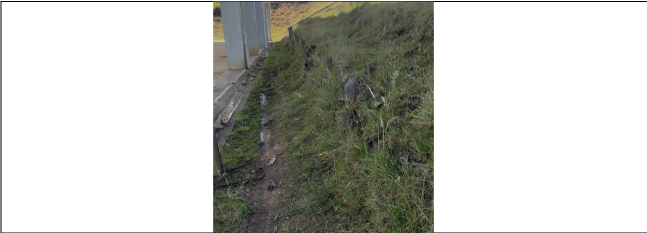
GAVION (JAC- Atraviesas Carrizal)
