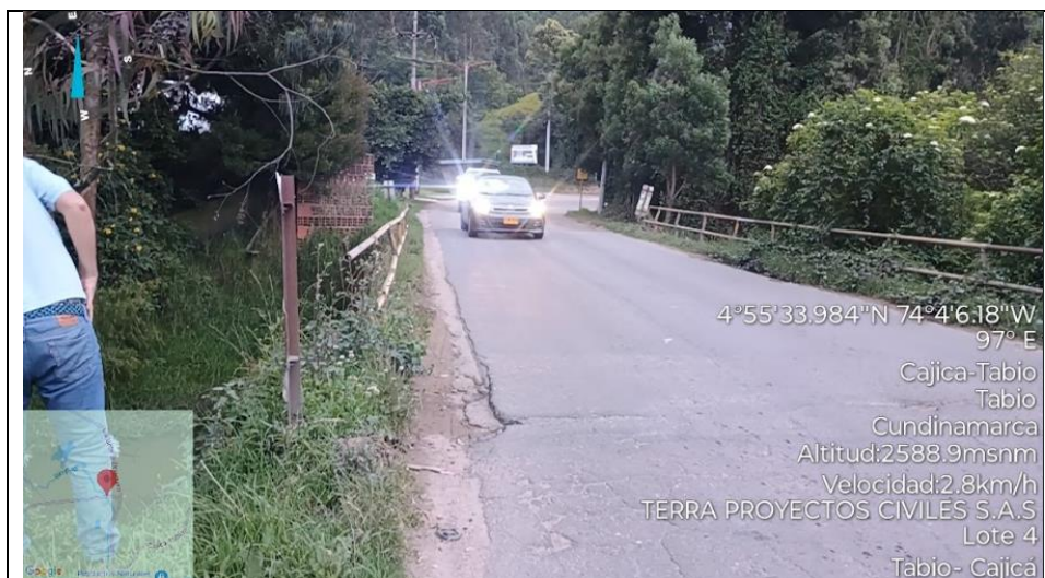
Visita en campo estado inicial Cajicá - Tabio
