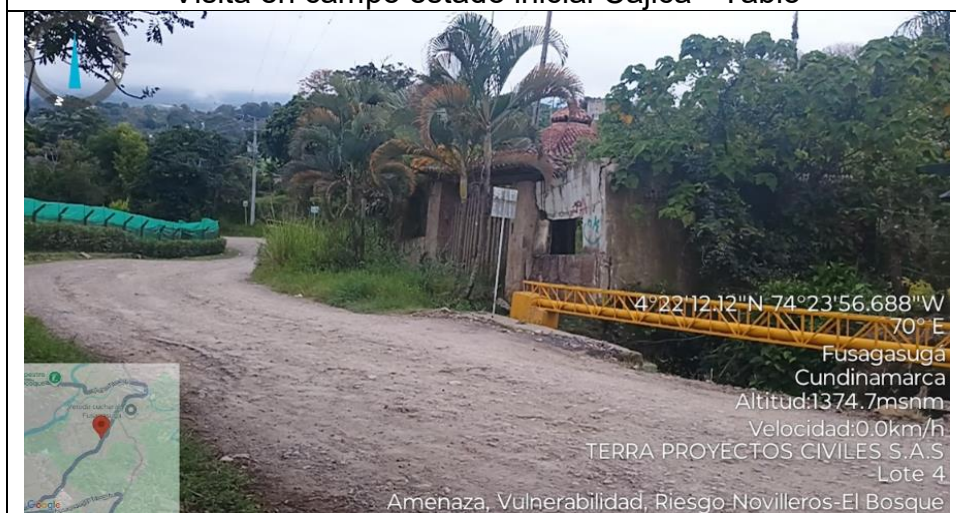
Visita en campo estado inicial Fusagasugá
