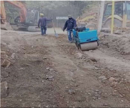
Fotografía 11. Compactación material relleno
