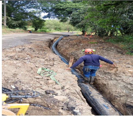
Fotografía 6. Instalación tubería. PEAD DN=355MM PN 10
