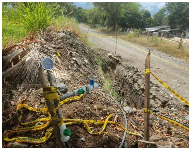
Ilustración 12. Realización pruebas hidrostáticas- Tramo 3
