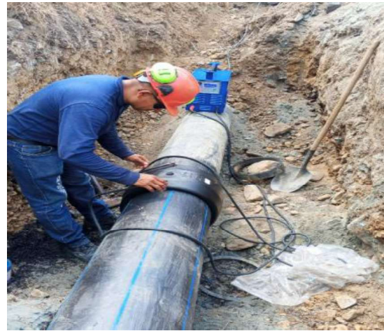
Fotografía 8. Instalación accesorios electro fundibles DN 450mm
