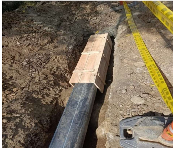
Ilustración 14. Anclaje de tubería en concreto reforzado
