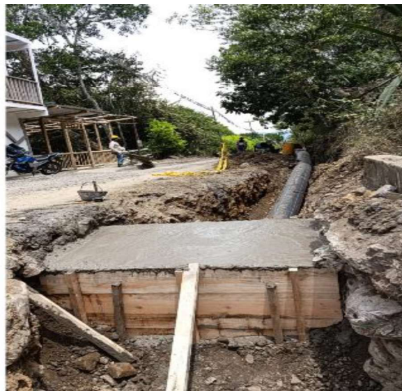
Ilustración 11. Construcción pase abscisa K2+902
