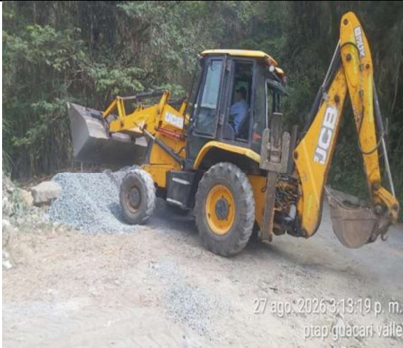
Recorridos en frentes de obra, inspección de maquinaria.
