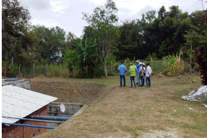
Ilustración 20. Recorrido para verificación conexiones a los tanques de almacenamiento
