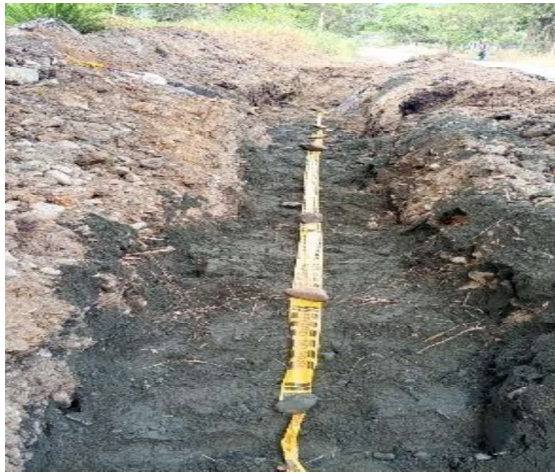
Fotografía 7. Instalación de cinta de señalización en zanja para advertir la presencia de tubería instalada en el sector.
