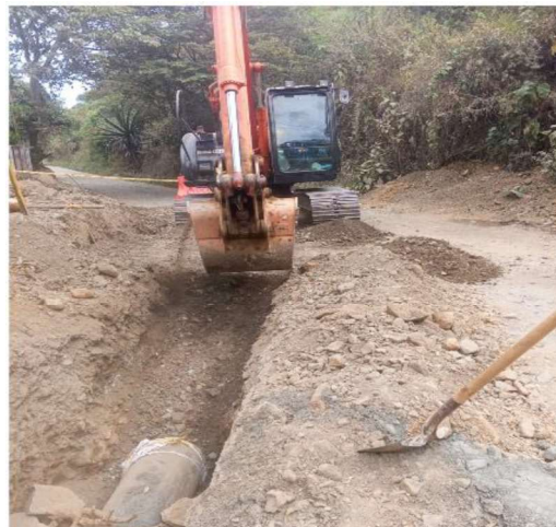
Ilustración 9. Cruce de tubería al costado opuesto de la vía- Tramo 1
