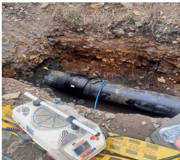
Ilustración 13. Instalación uniones electro fusión
