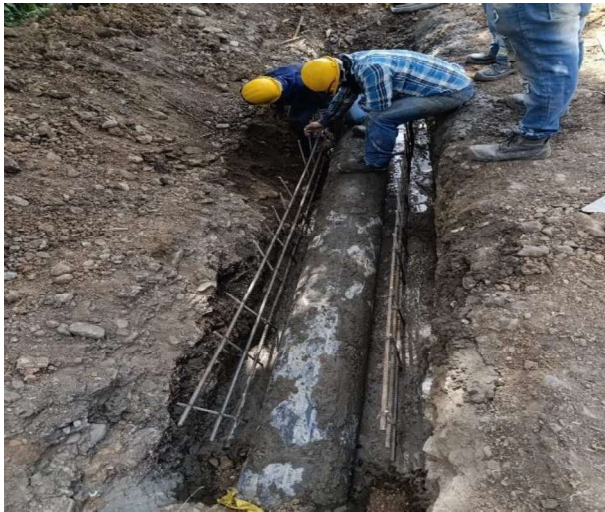
Ilustración 14. Anclaje de tubería en concreto reforzado
