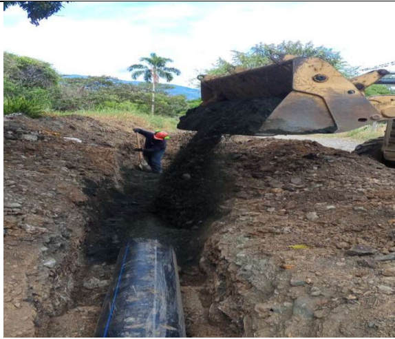
Fotografía 5. Instalación filtro granular
