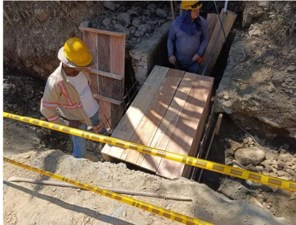
Ilustración 10. Construcción pase abscisa K2+787
