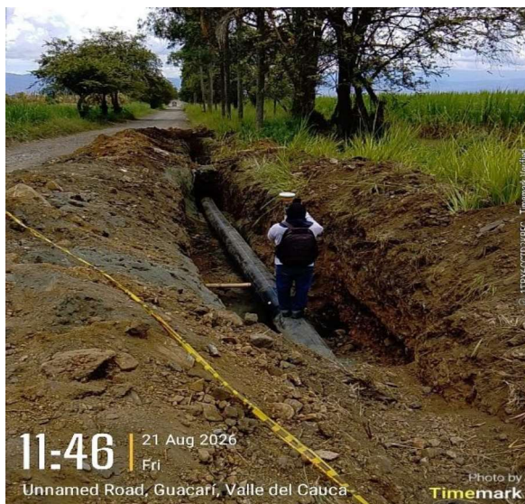
Ilustración 6. Ilustración 7. Referenciación instalación accesorios abscisa K3+570
