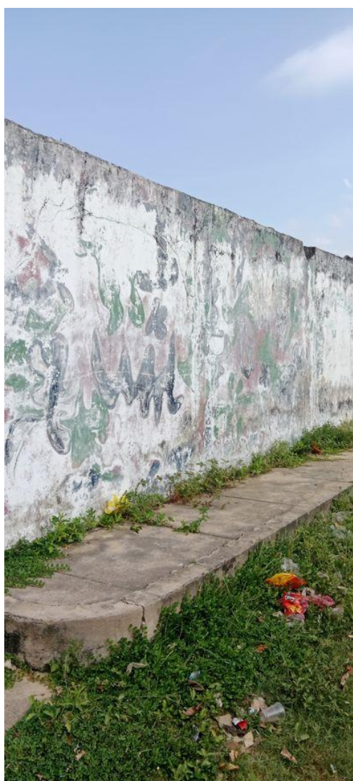
Registro fotográfico: IMG_20260511_152501.jpg
