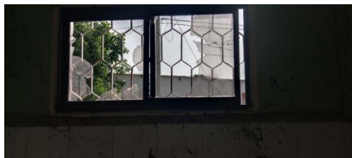
Registro fotográfico: IMG_20260511_154740.jpg
