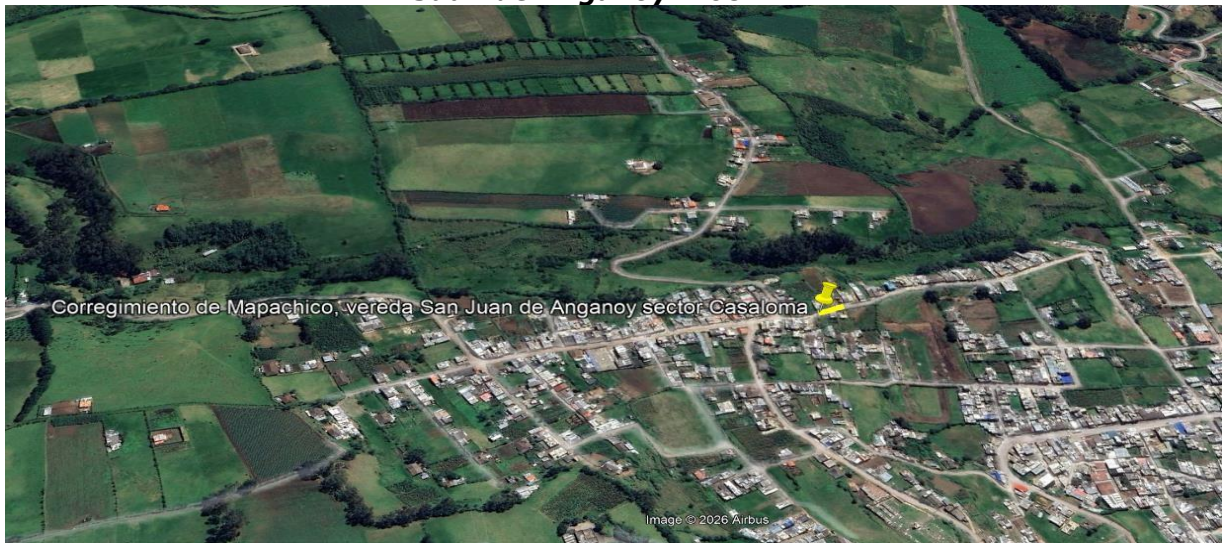
TRAMO 4: Mejoramiento con placa huella, Corregimiento de Mapachico, vereda San Juan de Anganoy. Sector Casaloma: 22 ML.
