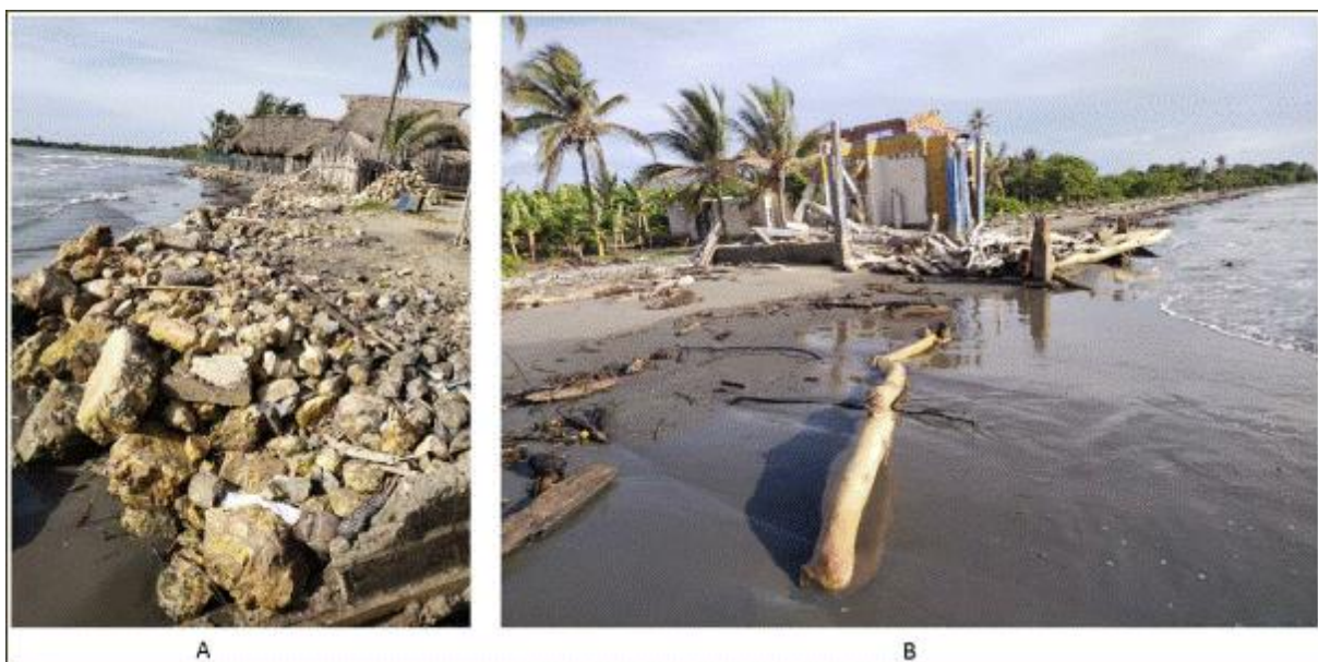
Figura 9 y 10. Imagen detallada de obras civiles Santander de la Cruz. Fuente: Aqua & Terra Consultores Asociados S.A.S., 2022.
