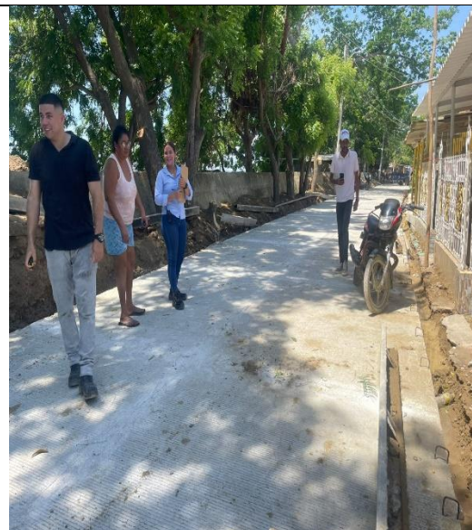
Imagen No.12. socialización de corte de pisos para construcción de andén en compañía de secretaria de planeación
