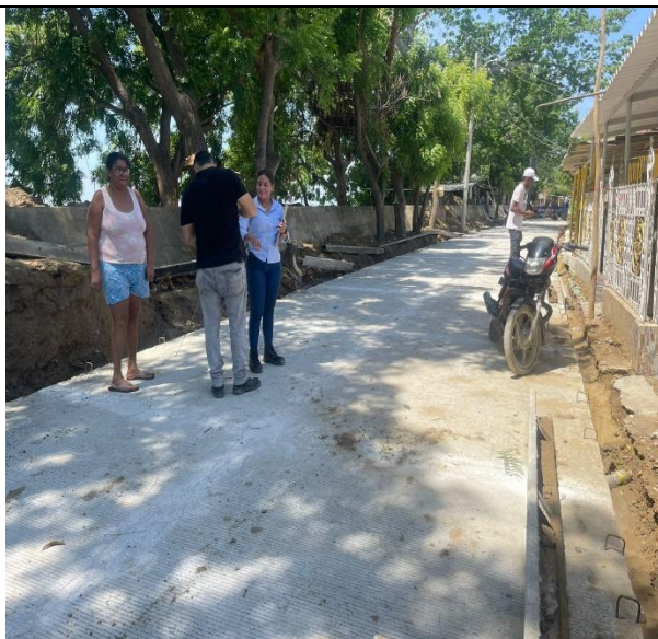
Imagen No.11 socialización de corte de pisos para construcción de andén en compañía de secretaria de planeación
