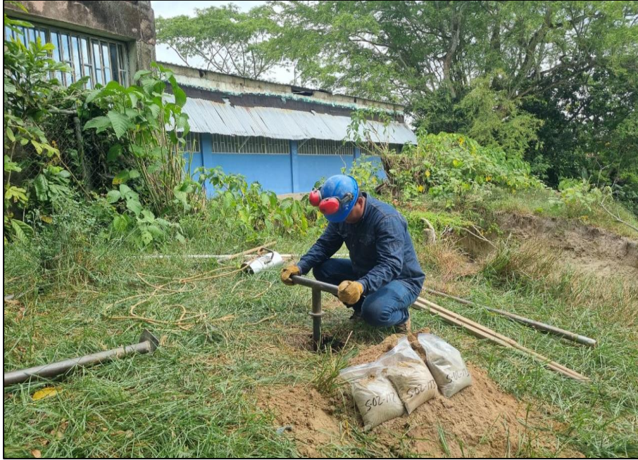
Foto 3. Sondeo exploratorio S-01 – Recuperación de muestra
