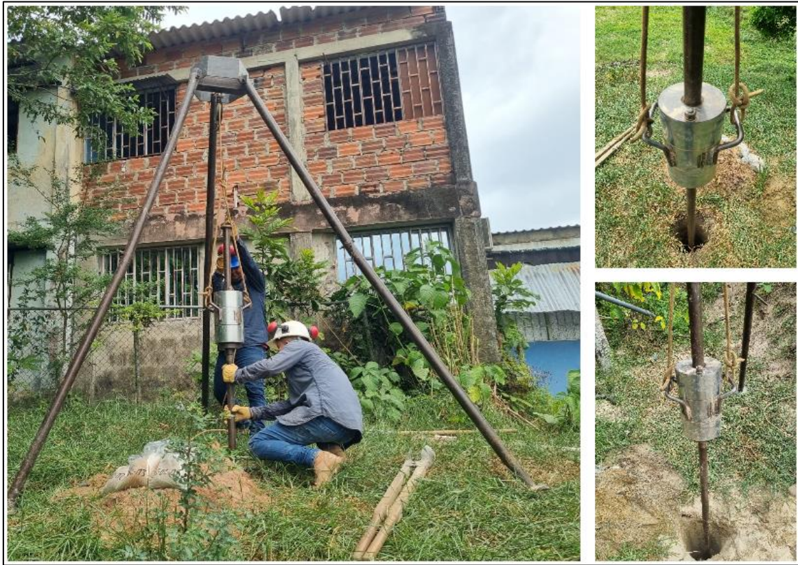
Figura 7. Detalle perforación y ensayo SPT
