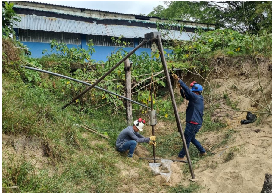
Foto 6. Sondeo exploratorio S-02 – Recuperación de muestra
