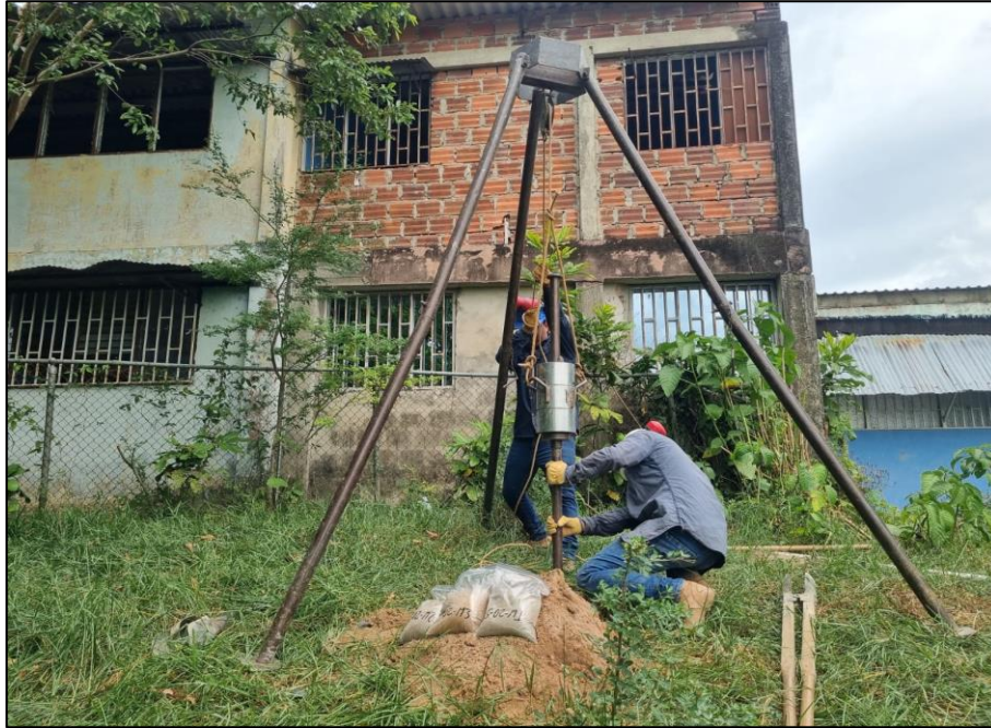
Foto 1. Sondeo exploratorio S-01 – Ensayo SPT
