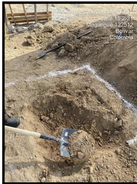
Ilustración 3. Trazado y excavación de zapatas de Locales Comerciales Bloque 1.
