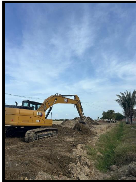
Ilustración 13. Excavación y relleno de tubería de colector de aguas pluviales mediante retroexcavadora.
