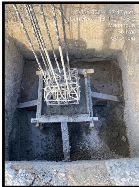
Ilustración 7. Formateado y fundida de pedestales en Locales Comerciales Bloque 2.
