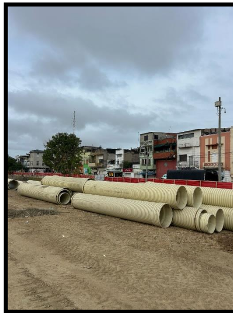
Ilustración 15. Suministro de tubería corrugada para colector de aguas pluviales.
