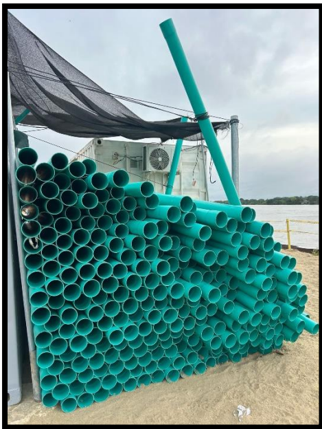
Ilustración 14. Suministro de tubería Conduit para instalaciones eléctricas.
