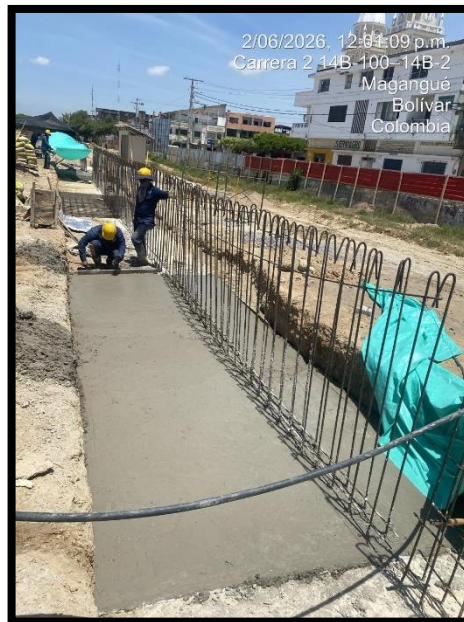
Ilustración 11. Fundida de cimentación en muro de contención en Locales Comerciales Bloque 2.
