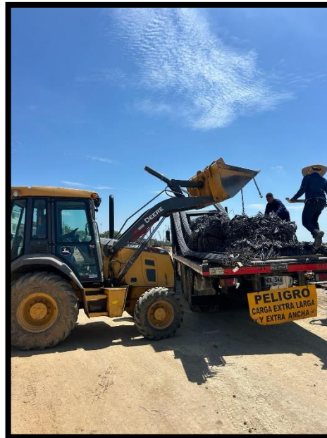
Ilustración 17. Suministro de acero de refuerzo para elementos estructurales.
