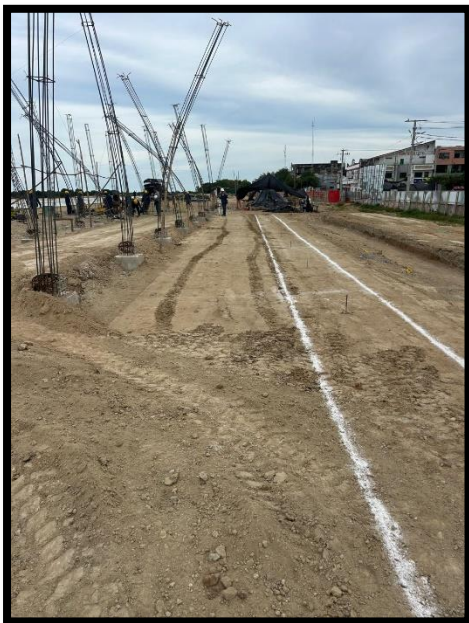
Ilustración 2. Trazado y replanteo de Muro de contención Locales Comerciales Bloque 2.
