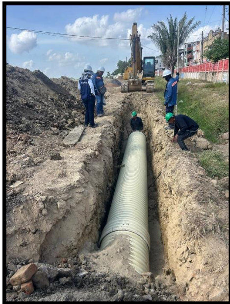
Ilustración 12. Instalación de tubería corrugada de colector de aguas pluviales.
