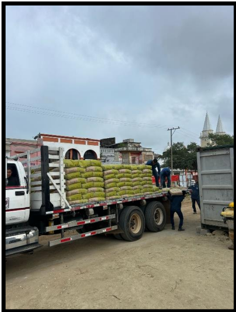
Ilustración 16. Suministro de cemento para elementos estructurales.
