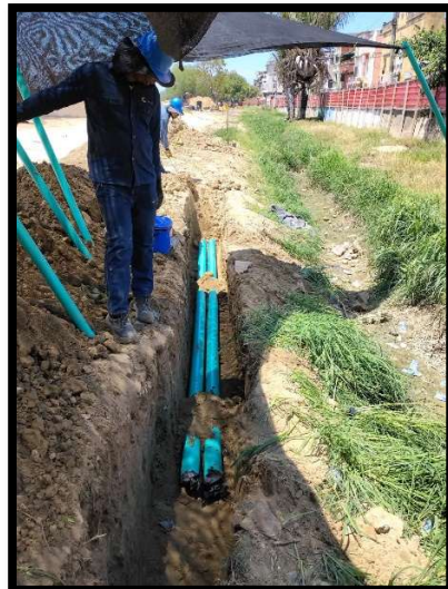
Ilustración 9. Instalación de tubería de Subestación eléctrica.
