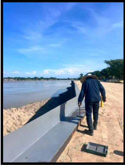
Ilustración 14. Pintura de anticorrosivo para formaleta de viga corona.
