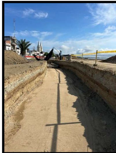
Ilustración 13. Excavación para zapara de graderías de la cancha No 2.
