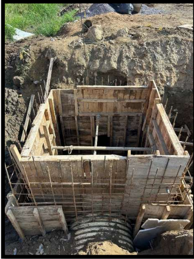
Ilustración 2. Encofrado de Manhole de colector pluvial.
