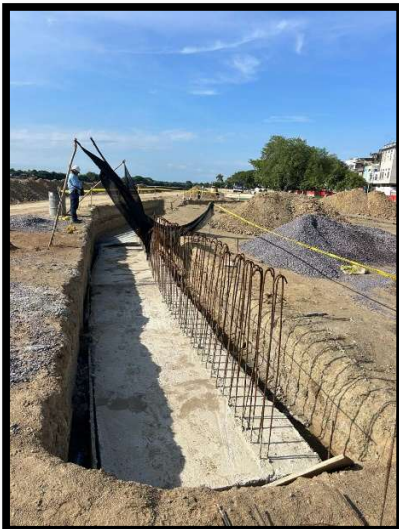
Ilustración 12. Muro de contención para escaleras y senderos peatonales.
