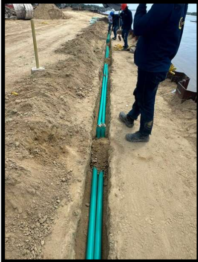
Ilustración 6. Instalación de tubería Conduit para iluminaria.
