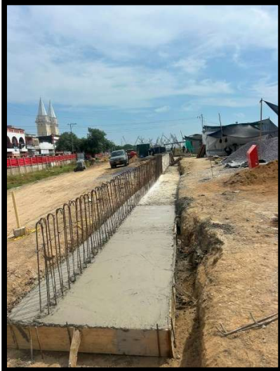
Ilustración 10. Muro rampa de sendero peatonal.
