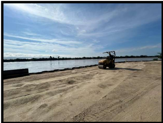
Ilustración 16. Compactación de material seleccionado.
