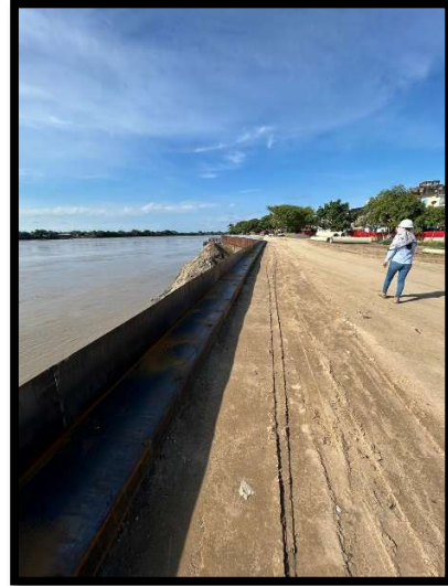
Ilustración 15. Instalación de formaleta de viga corona.
