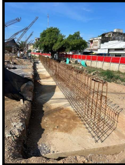
Ilustración 11. Muro de contención de locales comerciales No 1.
