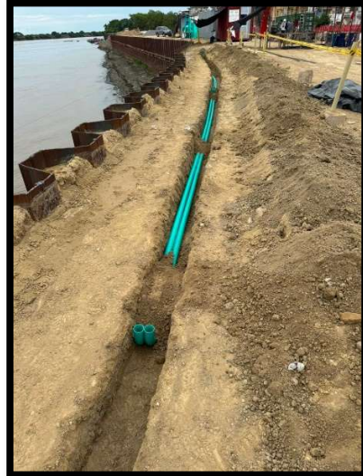
Ilustración 7. Instalación de tubería Conduit para iluminaria.
