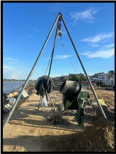
Ilustración 18. Fundación de pilotes mirador de plaza mayor.
