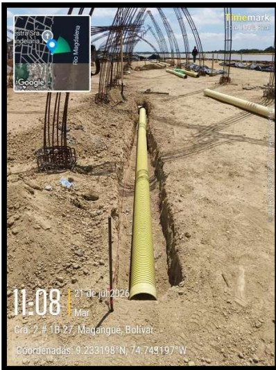
Ilustración 4. Instalación de tubería corrugada sanitaria Locales Comerciales No 1.
