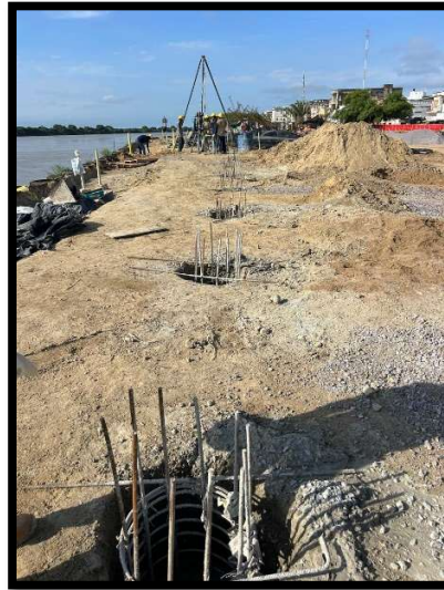
Ilustración 19. Pilotes de 5,6,7,8 y 9 metros fundidos.
