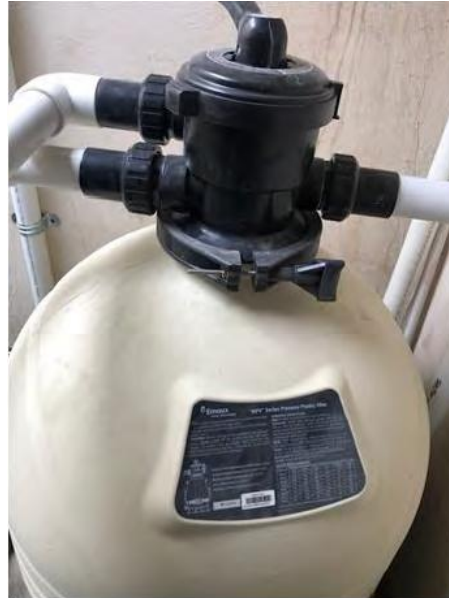
Imagen – Filtro Multimedia En Proceso de Instalación
