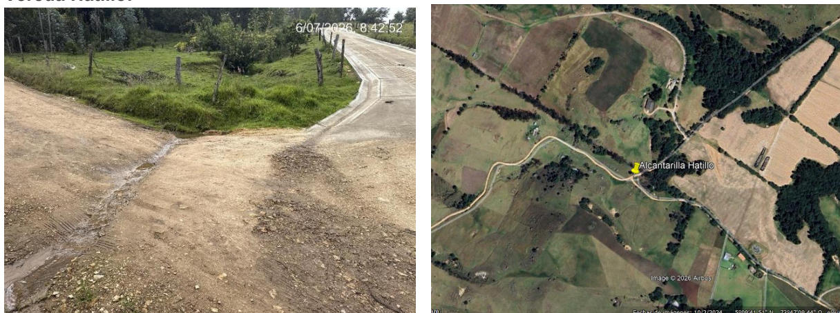
Imagen 2. Localización del punto de construcción de alcantarilla: 05°09'36.48"N - 73°47'21.44"O
