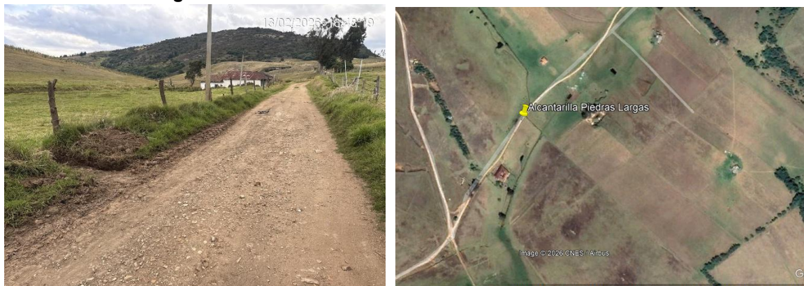
Imagen 1. Localización del punto de construcción de alcantarilla: 05°07'32.03"N - 73°49'13.19"O
