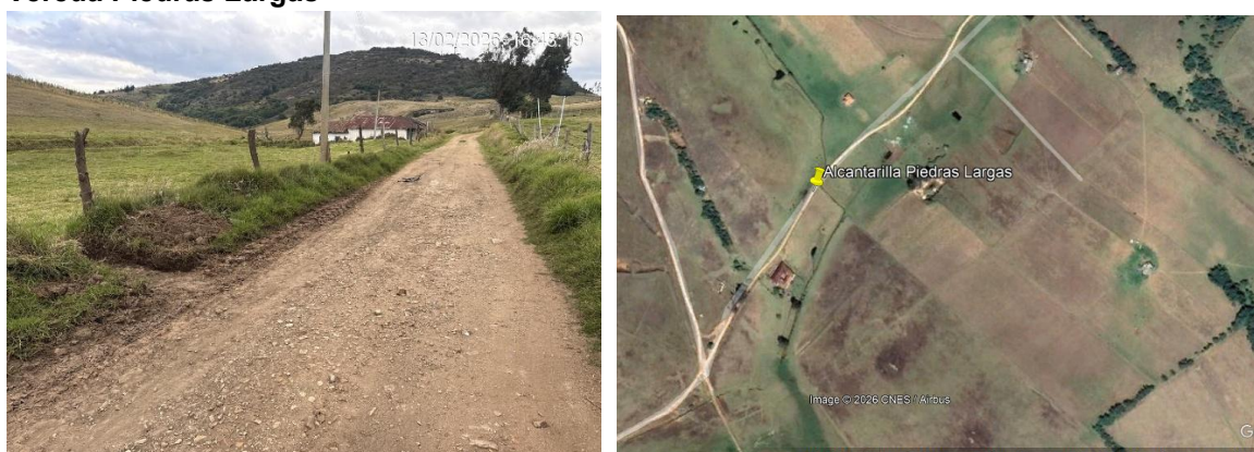
Imagen 1. Localización del punto de construcción de alcantarilla: 05°07'32.03"N - 73°49'13.19"O
